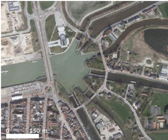
Figuur 2.8 Luchtfoto van het Ganzepootcomplex te Nieuwpoort. Beginnend in het noorden en in wijzerzin worden aangetroffen: het Nieuwbedelf, het kanaal Plassendale-Nieuwpoort, de Oude IJzer, de gekanaliseerde IJzer, de Noordvaart en het kanaal Duinkerke-Veurne. Het is een cruciaal punt voor de afwatering van het westelijk kustgebied.
