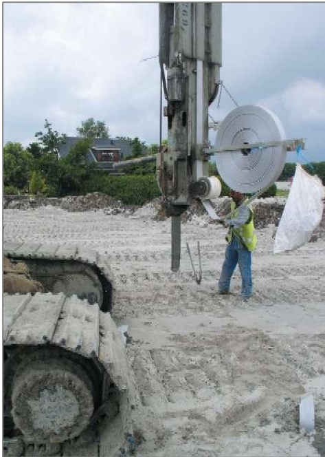
Figuur 2.1 Installeren van verticale drains vanaf de werkvloer.
