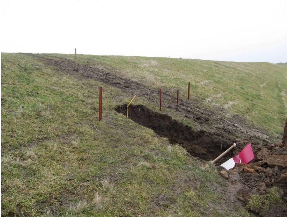
Figuur A.1 Oostelijke inspectiekuil
