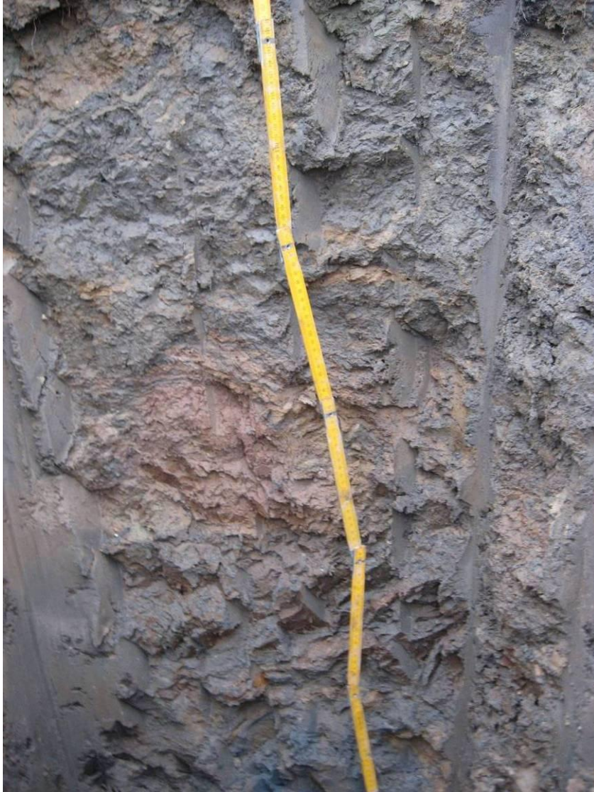
Figuur A.4 Oostelijke inspectiekuil: Losgestapelde blokkige structuur tussen 0.75 en 1.2 m –mv.
