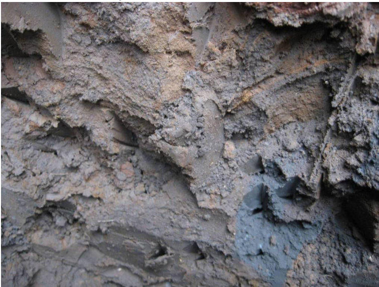
Figuur 0.6 Oostelijke inspectiekuil: Detail van de zachte en de "taai" keileembrokken (aanbrengen) op 1.6 – 1.8 m –mv.
