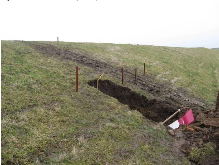
Figuur 0.1 Oostelijke inspectiekuil
