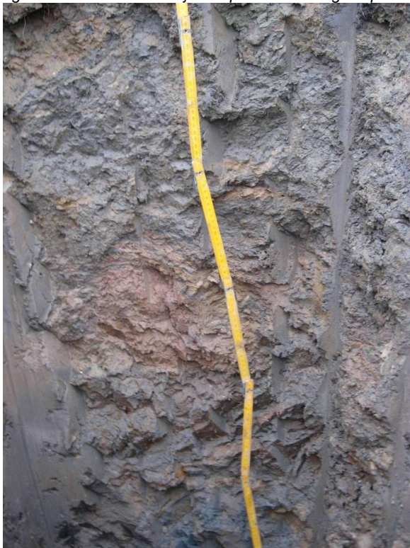
Figuur 0.4 Oostelijke inspectiekuil: Losgestapelde blokkige structuur tussen 0.75 en 1.2 m –mv.
