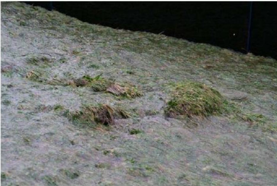
Figuur 4.5 Initiële schade teststrook 4
