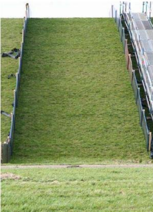
Figuur 4.2 Eindsituatie teststrook 2 (rechts overgang bij teen talud)
