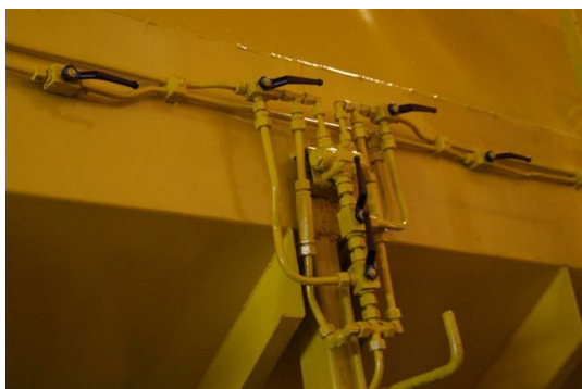
Foto 23. Hydrauliek voor gescheiden bediening kleppen
