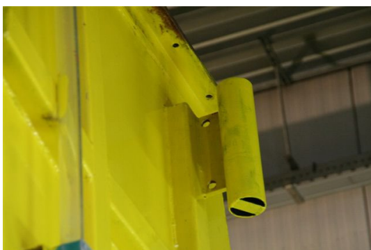
Foto 13. Koker voor vlaggenmast op oorspronkelijke simulator
