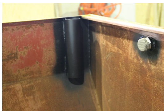
Foto 25. Koker in de hoek van de opzetbak voor bevestiging vlaggenmast
