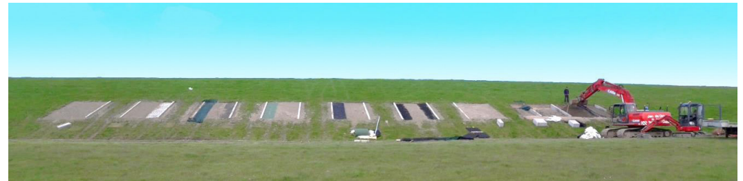
impressie van de aanleg van verschillende verticale overgangen met versterkingsmaatregelen.
