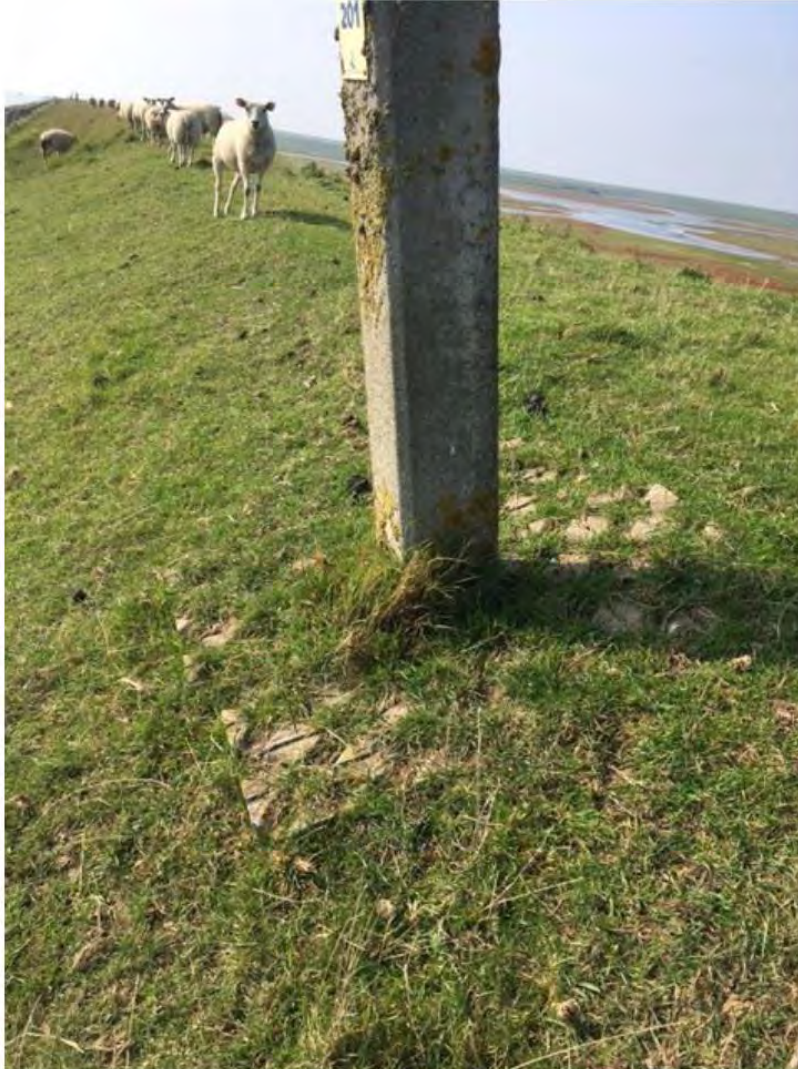
Figuur 2.1 Verbeteringsmaatregel door WSRL. In dit geval was er een door schapen uitgelopen plek rondom een paal. Herstellen van het gras heeft hier geen zin omdat dit weer opnieuw uitgelopen zal worden. Rondom de paal zijn doorgroeistenen aangelegd.
