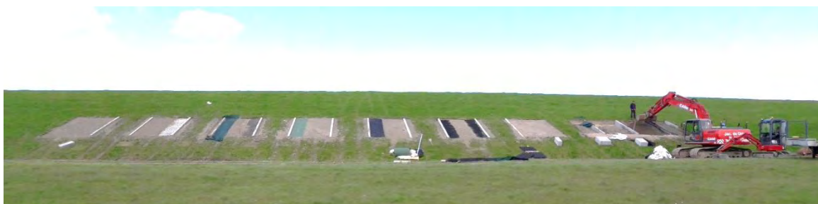
Figuur 6.1 Impressie van bouw van testsecties met verticale overgangen in een grasbekleding voorzien van versterkingsmaatregelen
