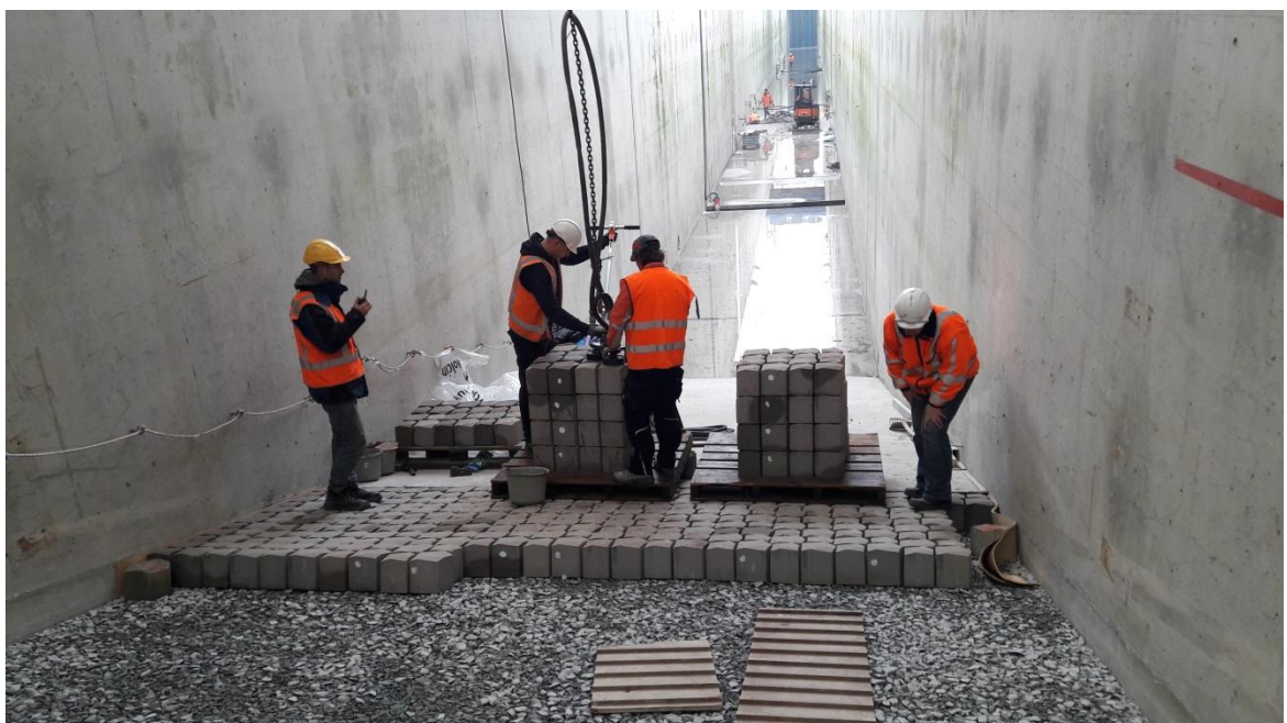
Figuur E.6 Plaatsen van de Quattroblocks met behulp van de zuignap
