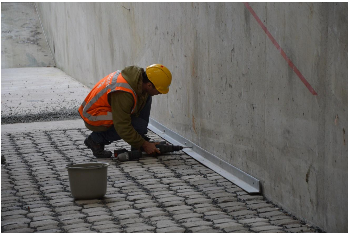
Figuur E.8 Aanbrengen van de stalen hoekprofielen langs de gootwanden
