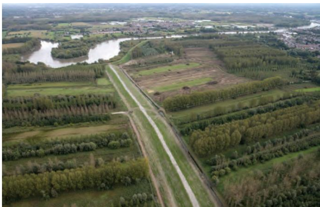
Figuur 31: Luchtfoto van opgeleverde compartimenteringsdijk Vlassenbroek (najaar 2013)
