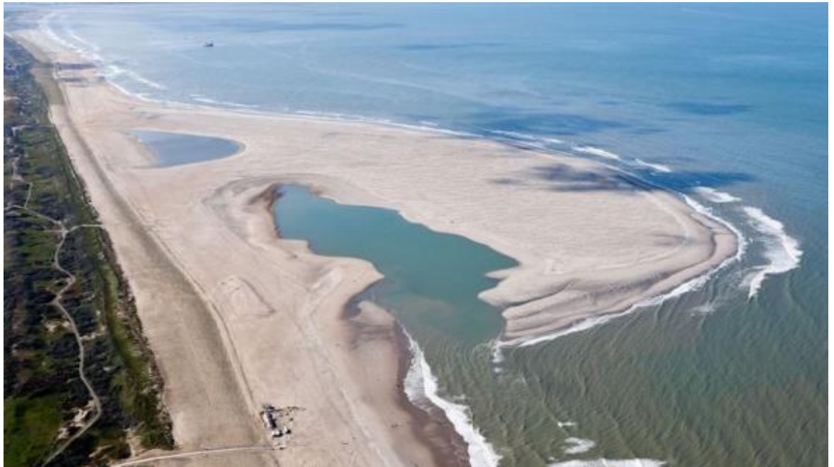
Figuur 1.1 Zandmotor na aanleg in Oktober 2011 (Rijkswaterstaat / Joop van Houdt)
