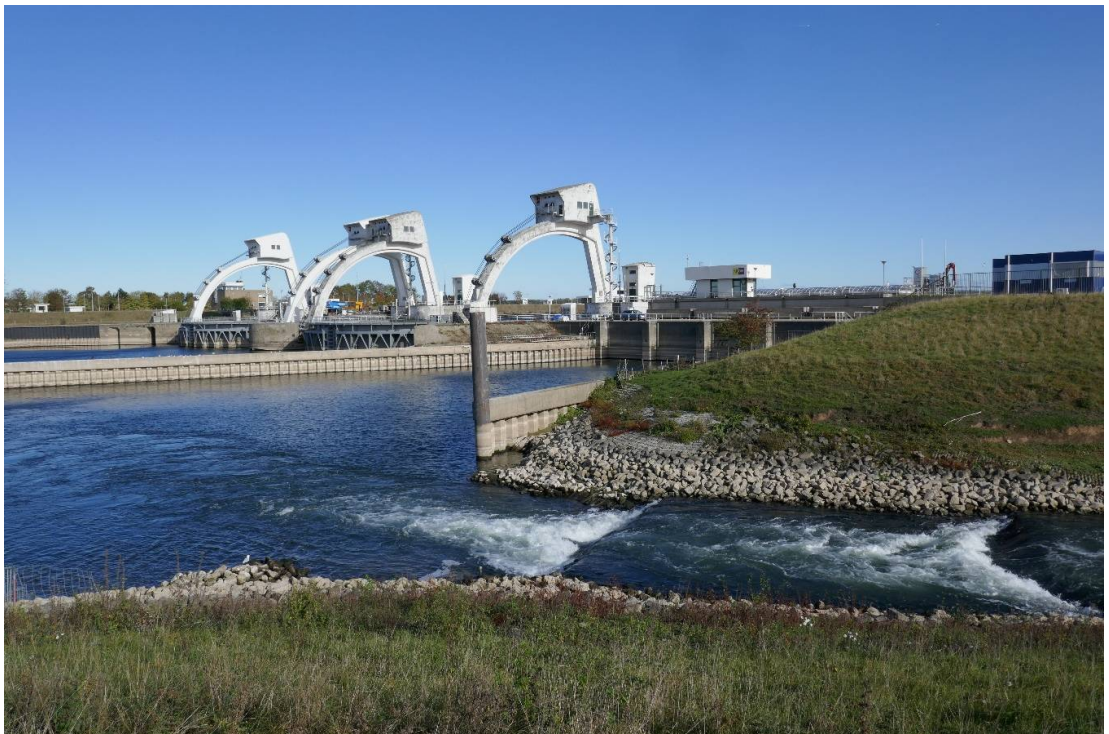
Foto D.5 Stuw Amerongen tijdens laagwater periode (2018). Uitstroming vistrap, waterkrachtcentrale en de gesloten vizierstuwen. (Foto: Persoonlijk archief Jurjen de Jong)
