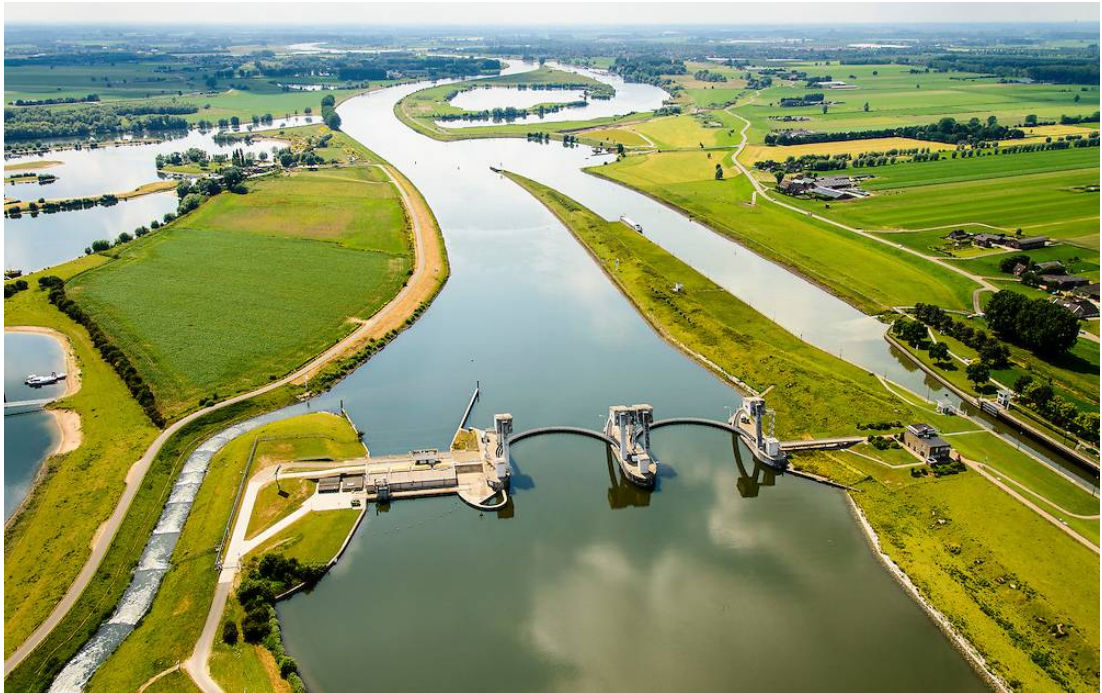
Foto A.5 Overzichtsfoto van het stuwcomplex Amerongen in benedenstroomse richting, met links direct naast de vizierschuiven de WKC Amerongen en meest links de vistrap (bron: wikimapia.).
