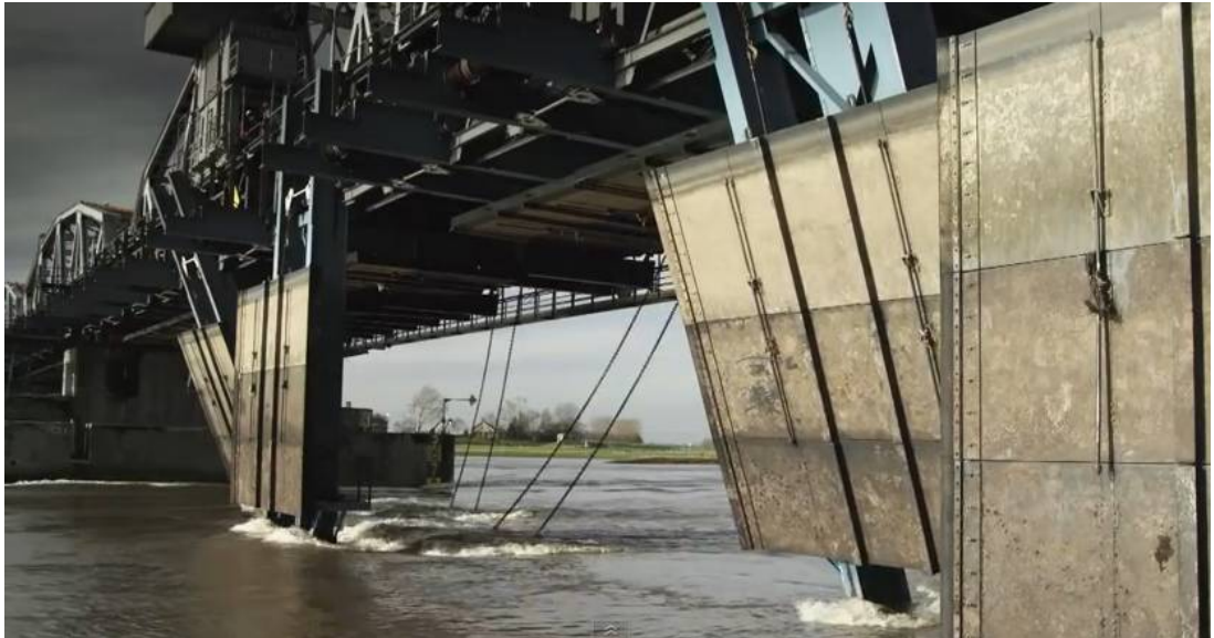
Foto D.4 Linksboven: De 11 jukken met hierop de rijen schuiven onder het meest westelijke deel van de brug, met aan weerszijden de grijze kraanwagens. Rechtsboven: Detailopname van het oostelijke stuwdeel waarbij 1 schuif van de bovenrij (links op de foto) getrokken is. Midden: Overzicht van de gehele stuw in een situatie waarbij de stuw bijna is gestreken. Onder: De stuw wordt gestreken en 2 van de 4 jukken hangen reeds "op stroom". (Van Aubel, 2016).
