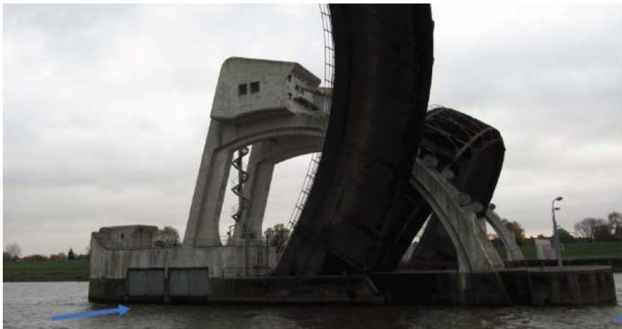
Foto D.7 In- en uit stroomlocaties van de cilinderbuis in de middenpijler van het stuwcomplex (Spijker, 2013)
