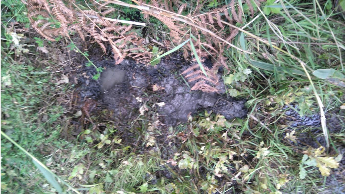
Figuur 7. Situatie bij kwellocatie na beperkt ontgraven
