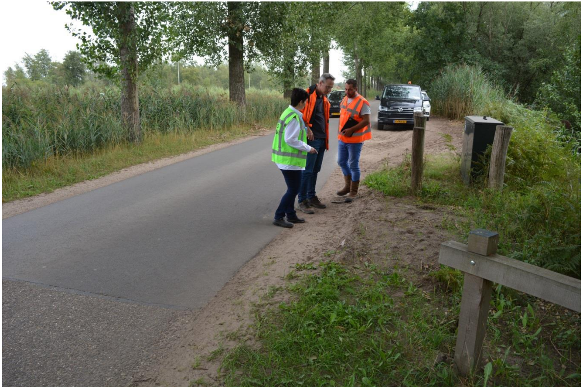
Figuur 10. Gevulde gat naast de weg en nieuwer asfalt (zie ook figuur 1)
