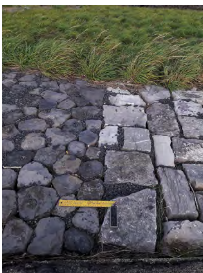
Foto 22: Plaats: Den Oever, Datum: 24 oktober 2018
