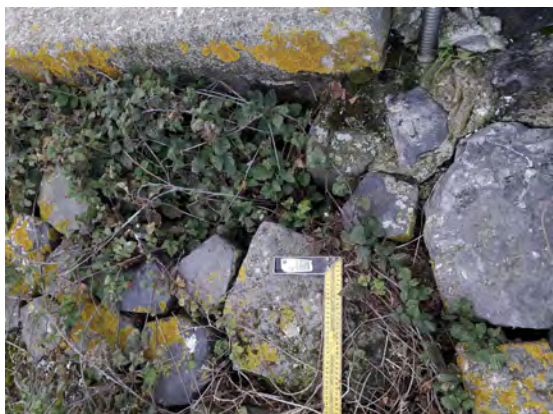
Foto 44: Plaats: Den Oever, Datum: 24 oktober 2018
