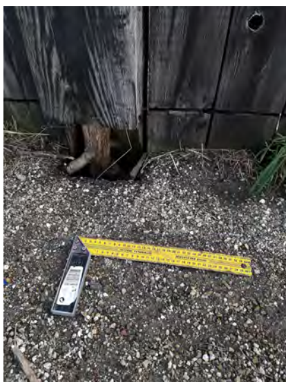
Foto 112: Plaats: Den Oever, Datum: 24 oktober 2018
