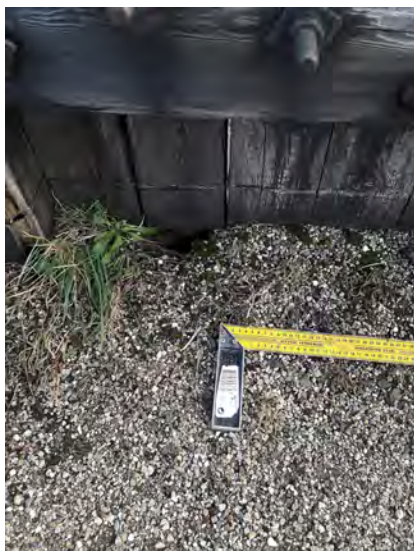
Foto 111: Plaats: Den Oever, Datum: 24 oktober 2018
