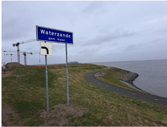
Figuur 2.8. Bord bebouwde kom Waterzande met op de achtergrond de werkzaamheden boven het voormalige veerplein.
