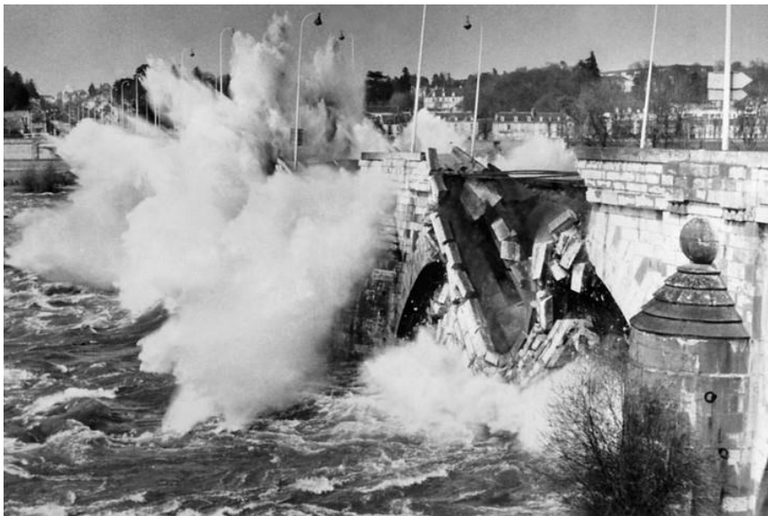
Figuur 2.4 Instorten van de Pont Wilson over de Loire op 9 april 1978 als gevolg van een diepere ligging van het zomerbed 1 .
