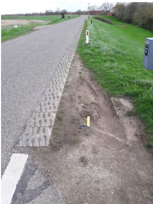
Figuur 7.1 Voorbeeld van paaltjes in de grasbekleding, het betreft hierbij hectometerpaaltjes
