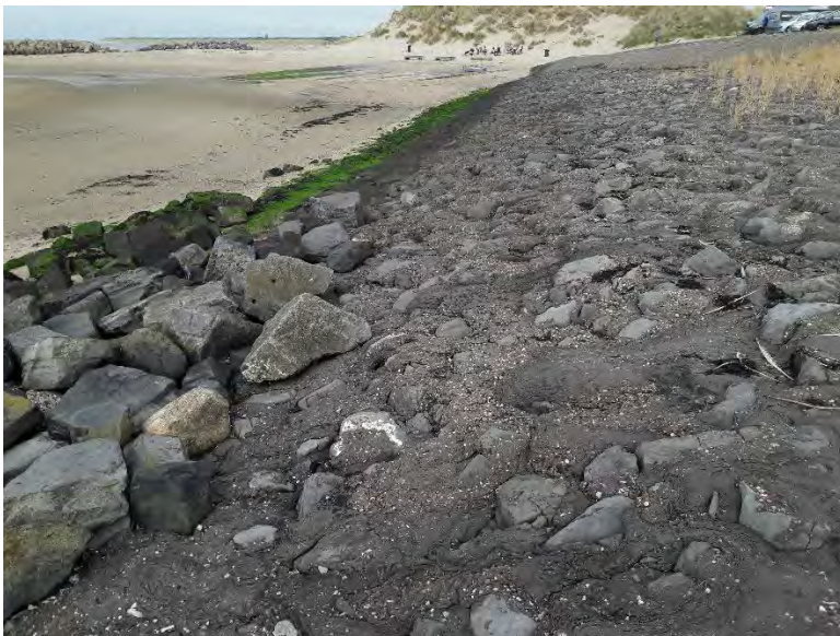
Figuur 2.4 Teenconstructie van met asfalt gepenetreerde breuksteen
