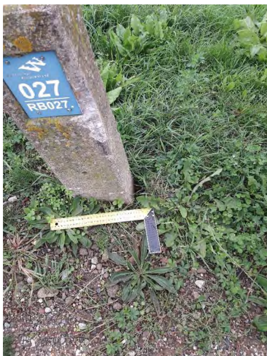
Figuur 7.3 Dijkpaal die enigszins uit het lood staat
