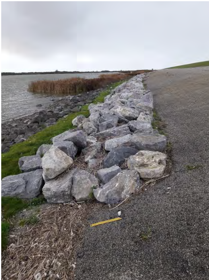
Figuur 2.5 Breuksteen op overgang asfaltbekleding - voorland
