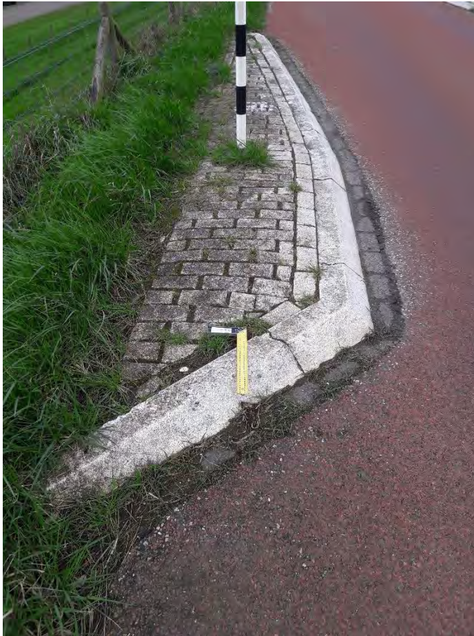
Figuur 6.3 Obstakel om een wegversmalling te realiseren
