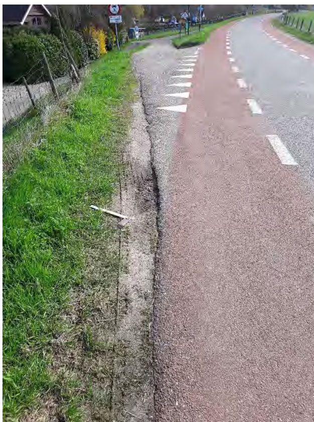
Figuur 9.7 Oprit van een weg op het binnentalud
