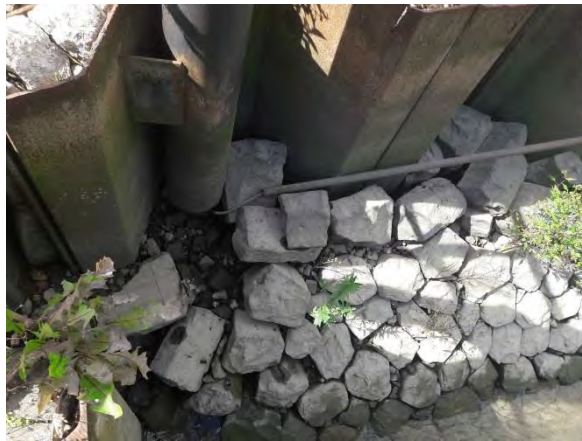
Figuur 4.5 Steenbekleding voor een damwand [Deltares (2018a)]
