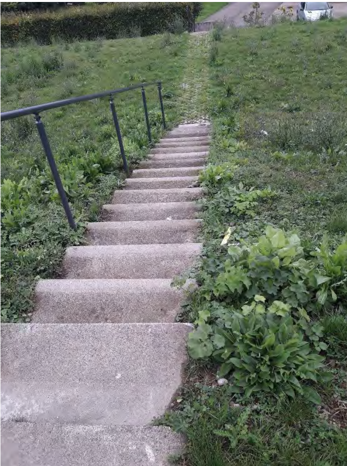
Figuur 6.1 Overgangen tussen een trap en een grasbekleding op het binnentalud van een dijk
