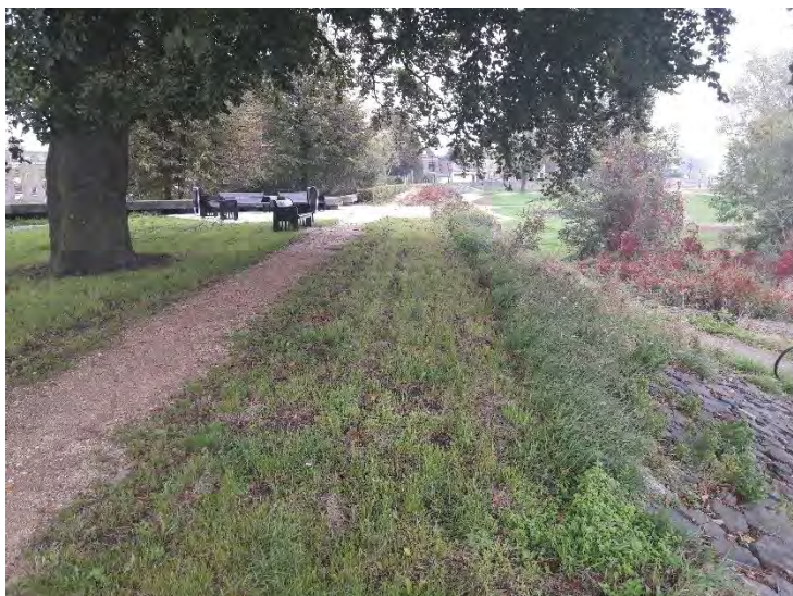
Figuur 9.8 Boom op de kruin van een dijk
