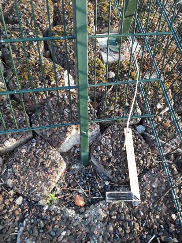
Figuur 9.9 Paaltjes in een steenbekleding op het buitentalud
