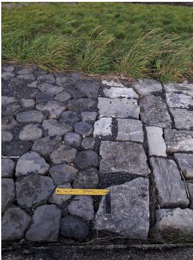
Figuur 9.5 Verticale overgang tussen twee typen steenbekleding
