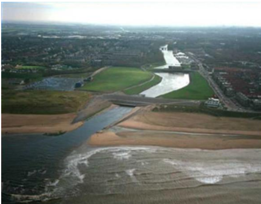
Figuur 5.1 Uitwateringssluis in Katwijk. Bron: Beeldbank RWS
