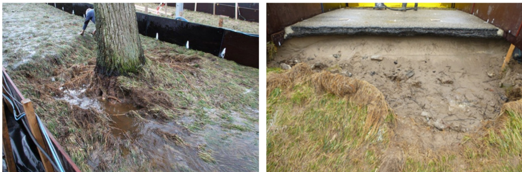
Figuur 1.1 Boom in een grasbekleding en een asfaltweg op de kruin van de dijk
