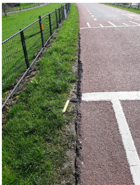
Figuur 4.4 Voorbeelden 'nette' overgang, maar met een plaatselijk mindere kwaliteit grasbekleding
