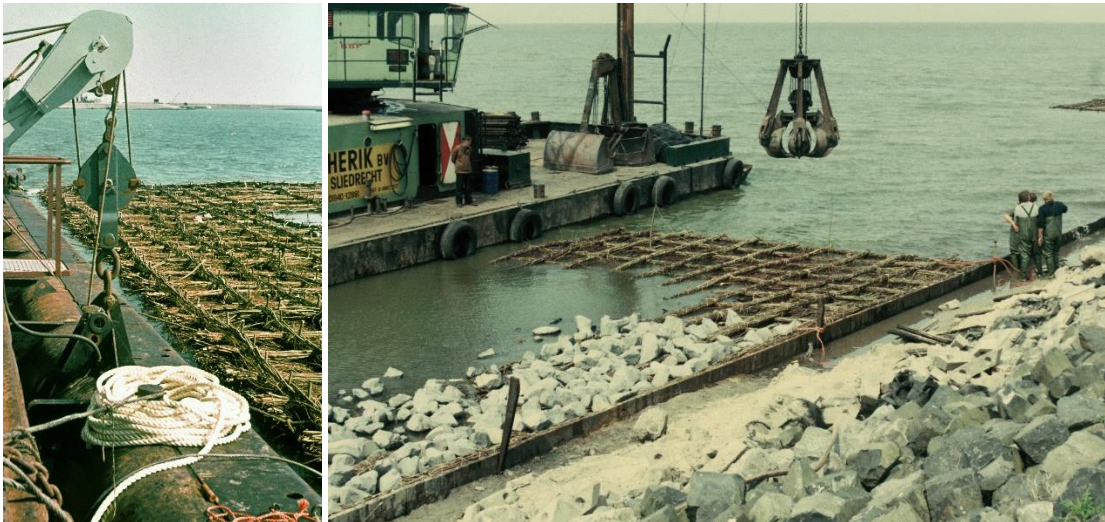
Figuur 1-1 Aanleg oeverwerk; links positioneren zinkstuk, rechts bestorten van een zinkstuk (foto's RWS Beeldbank)
