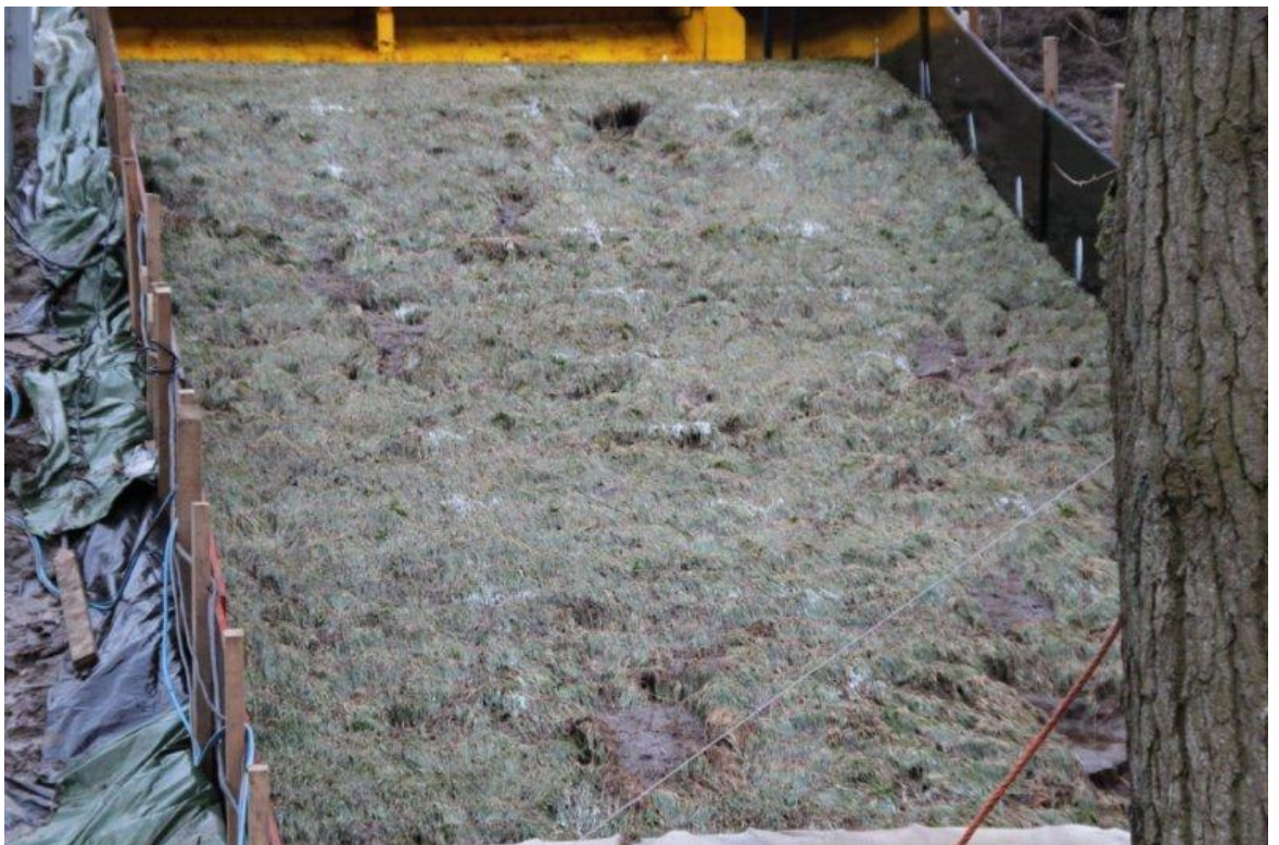
Foto B45 Vechtdijk. Zeeregime met boom, proef 2; Gestopt, talud niet bezweken
