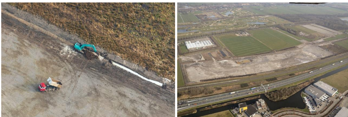
Figuur 1.6 Luchtfoto's van het werk op 20 februari 2019.
