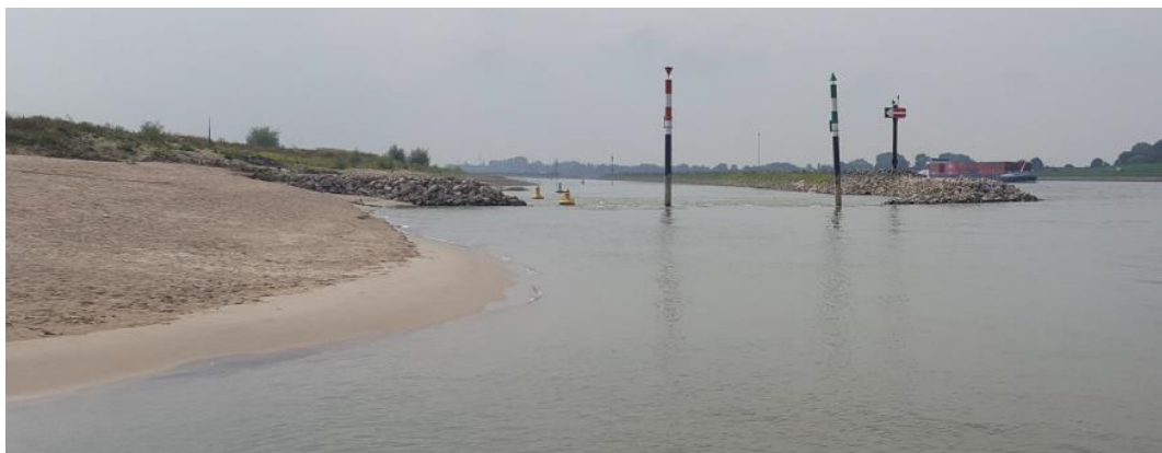
Figuur 5-2. Inlaatopening van langsdam bij Dreumel tijdens lage afvoer van 907 \text{ m}^3/\text{s} op 4 september 2018.
