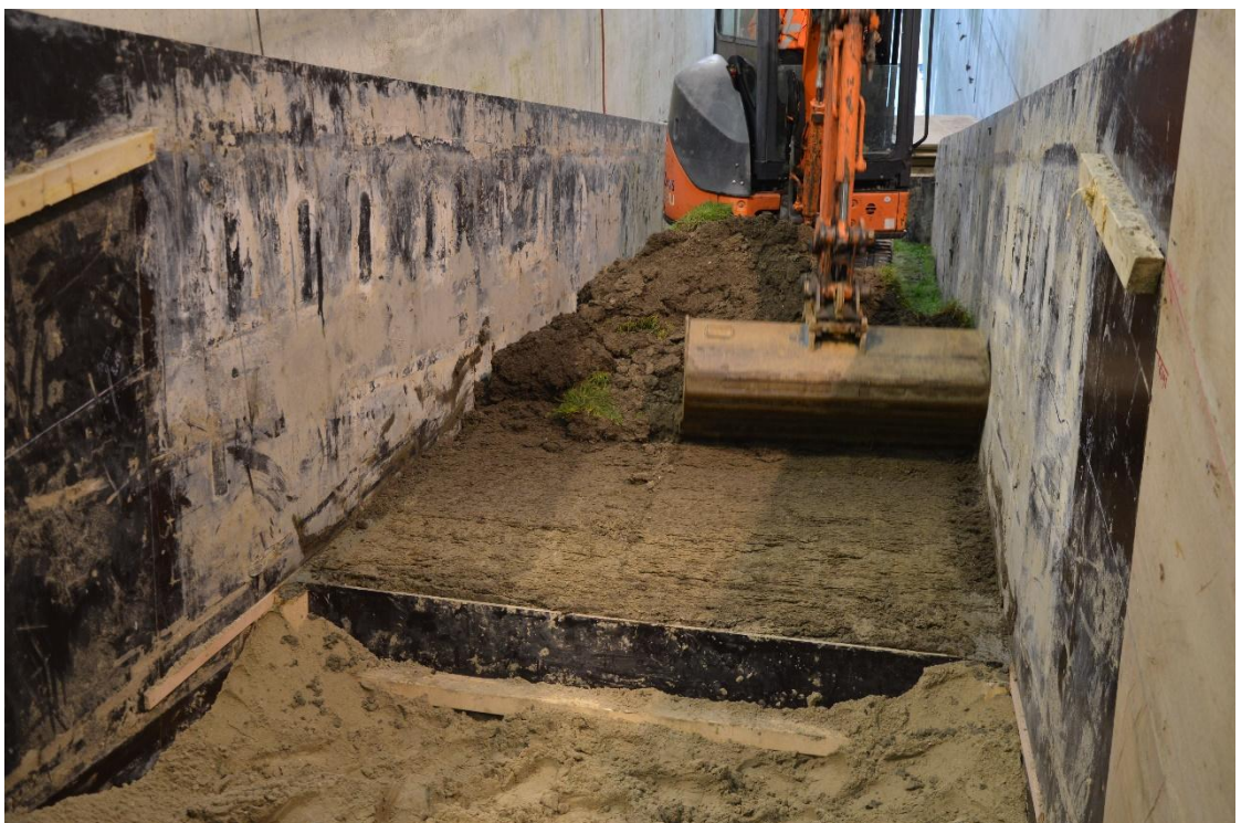
Fig. B-118 Graslaag van onderste laag kleiblokken verwijderen
