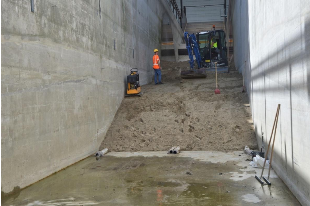
Fig. B-1 Aanleg van de zandkern van het ondertalud
