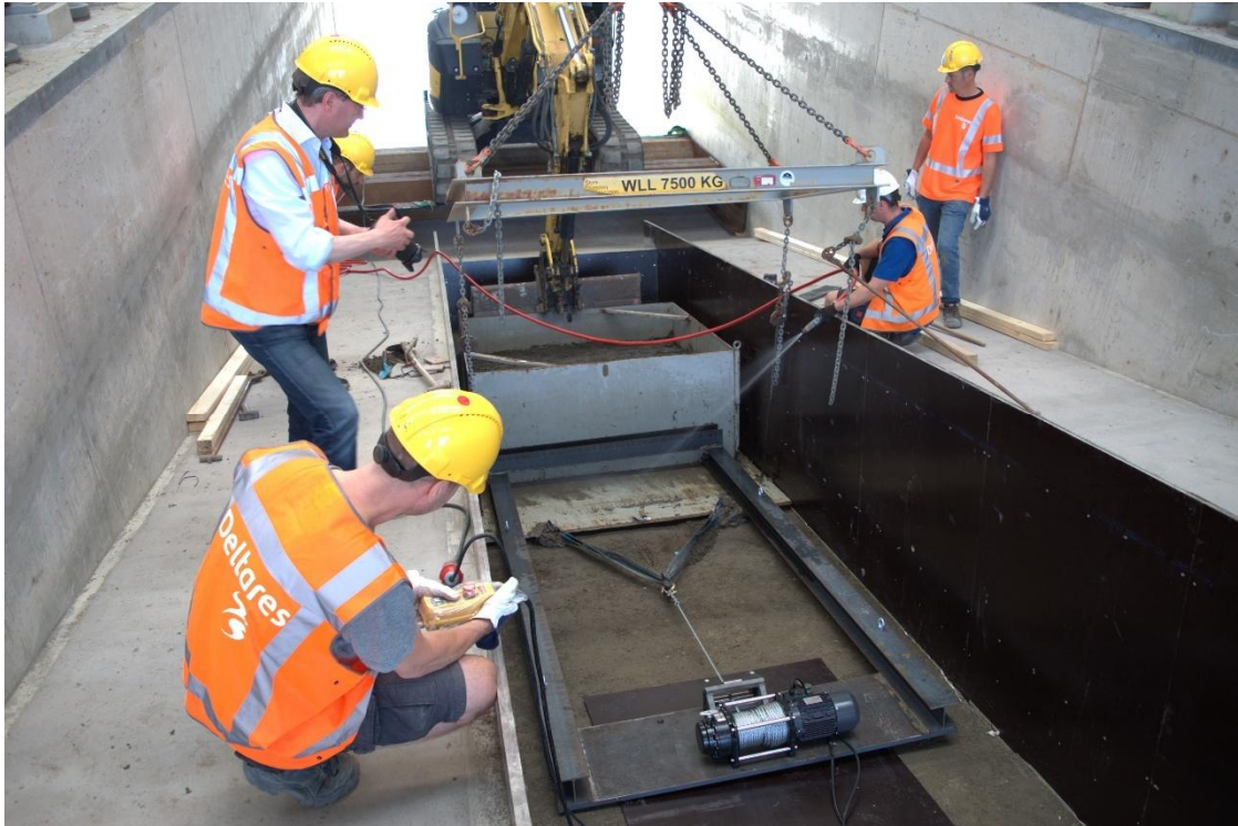
Fig. B-13 Staalplaat onder het eerste kleiblok uittrekken met een lier op een frame. Er wordt water op de staalplaat gespoten als smeermiddel bij het uittrekken van de staalplaat.
