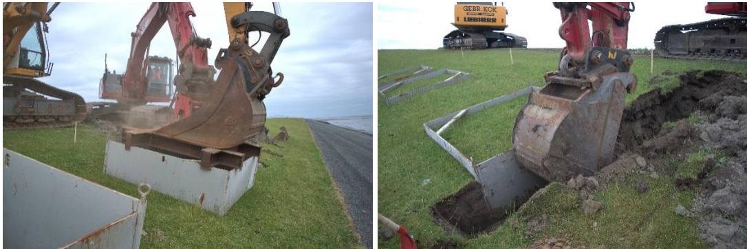
Figuur 3.2 Stalen mal in taludoppervlak drukken en vervolgens rondom vrijgaven
