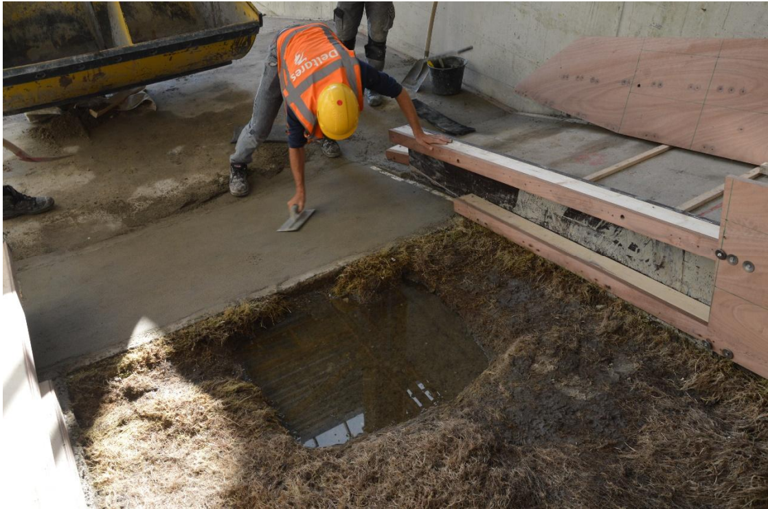
Fig. B-73 Aanbrengen van zandcement op aansluiting naar de overgang met het gras
