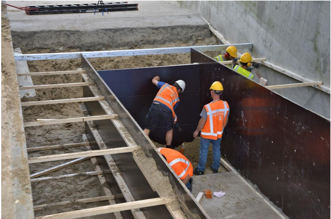
Fig. B-7 Overgangsconstructie monteren
