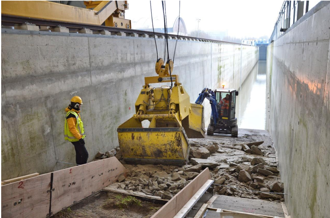
Fig. B-129 Verwijderen van de berm
