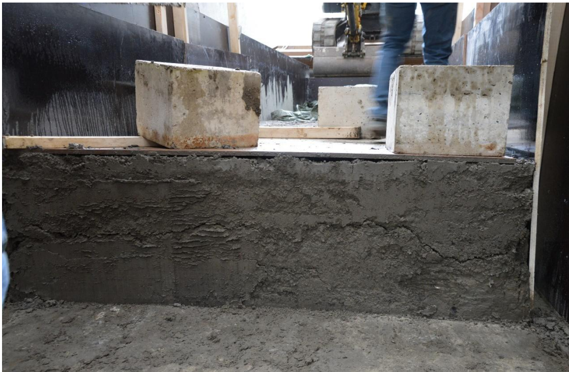
Fig. B-16 Onderste laag kleiblokken is gereed
