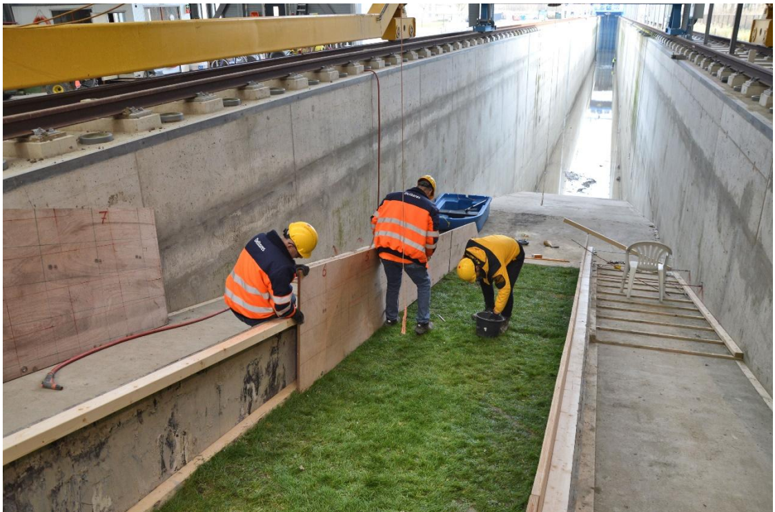
Fig. B-120 Plaatsing van houten schotten boven het gras
