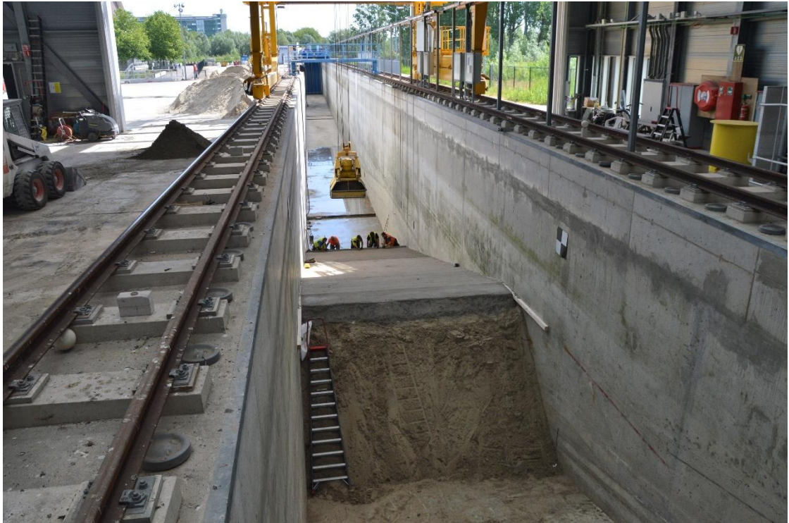
Fig. B-3 Zandcement aanbrengen op het ondertalud
