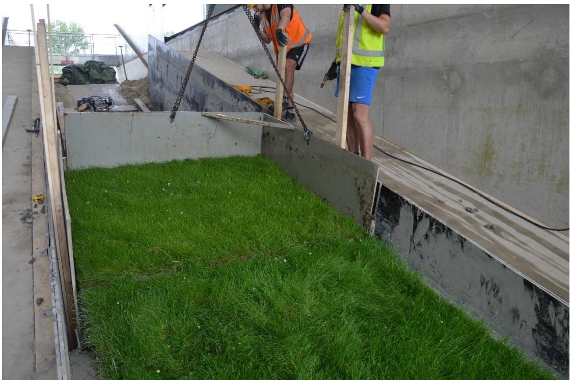
Fig. B-58 Het lichten van de zijkant van de stalen mal bij het plaatsen van de grasblokken
