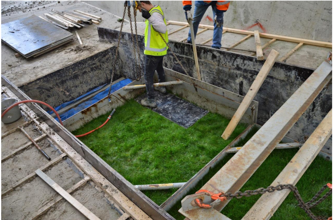
Fig. B-117 Lichten van de zijkant van de stalen mal van het kleiblok
