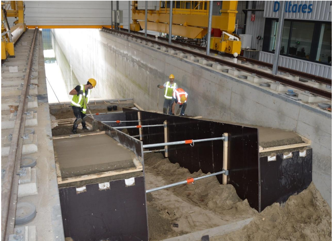
Fig. B-9 Zandcement aanbrengen op de stoepen naast het gras
