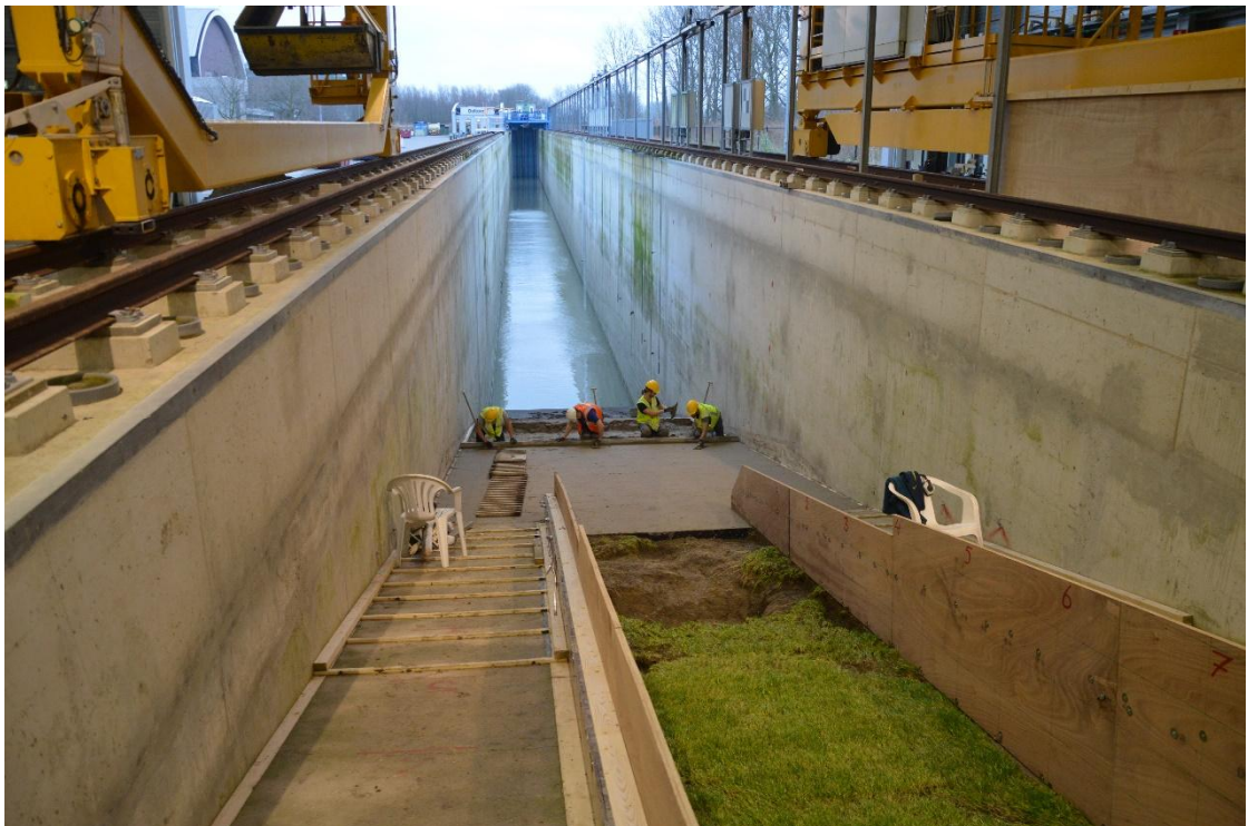
Fig. B-130 afwerken van het talud met helling van 1:5
