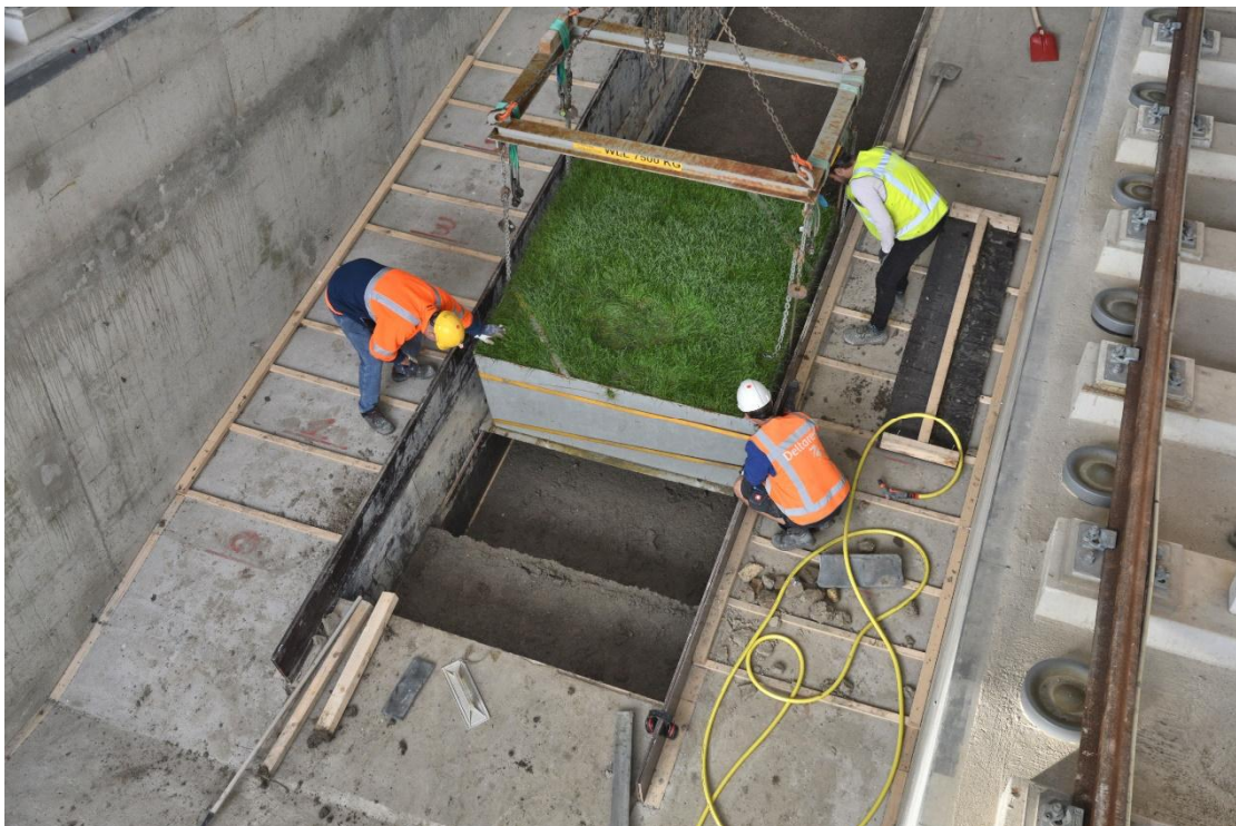
Fig. B-87 Plaatsing eerste kleiblok
