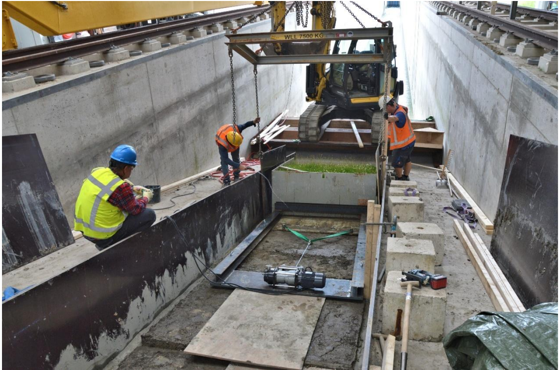
Fig. B-17 Staalplaat onder eerste kleiblok met gras uittrekken
