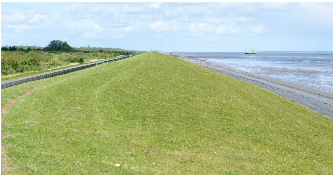
Figuur 1.1 Dijkbekleding van gras op een kleilaag op de dijk Lauwersmeerdijk-Vierhuizergat
