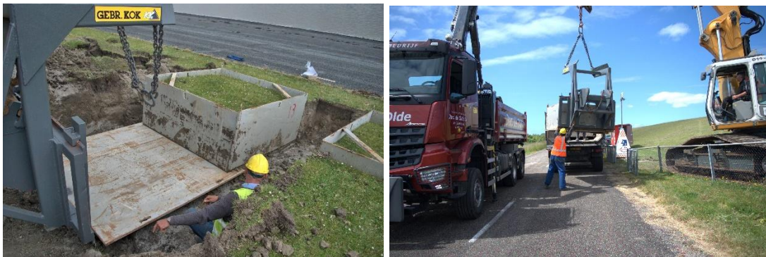
Figuur 3.3 Staalplaat eronder drukken en vervolgens in de vrachtwagen laden
