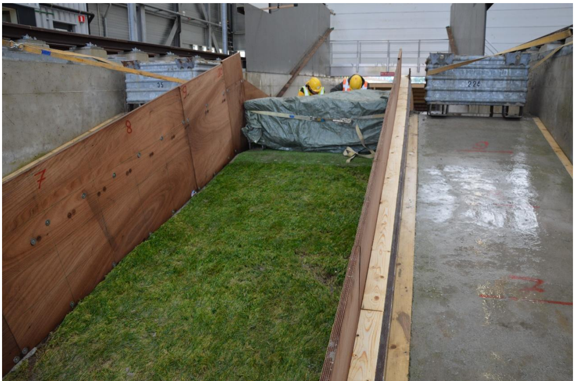
Fig. B-142 Om de golfoverslag te beperken en te zorgen voor voldoende golfneerloop zijn er stalen balken op de kruin geplaatst voor proef K6_09
