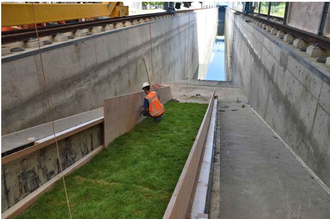
Fig. B-60 Houten platen langs het gras plaatsen
