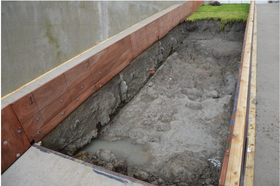
Fig. B-47 Erosiekuil na proef K1_12
