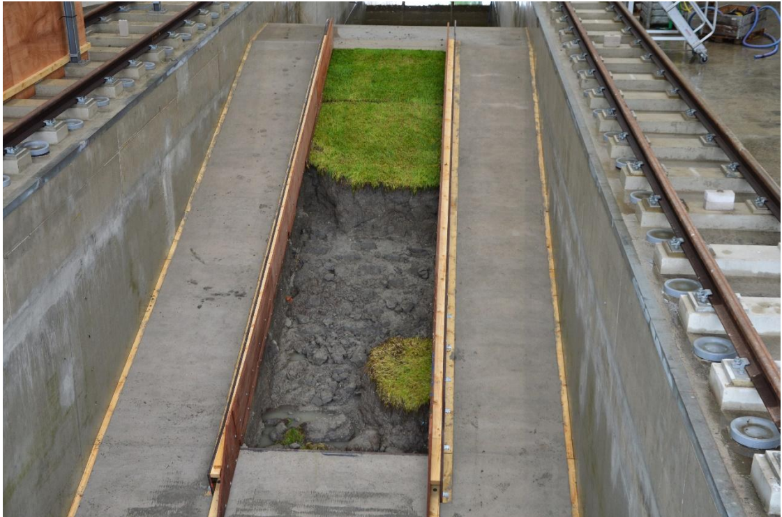
Fig. B-45 Erosiekuil na proef K1_11
