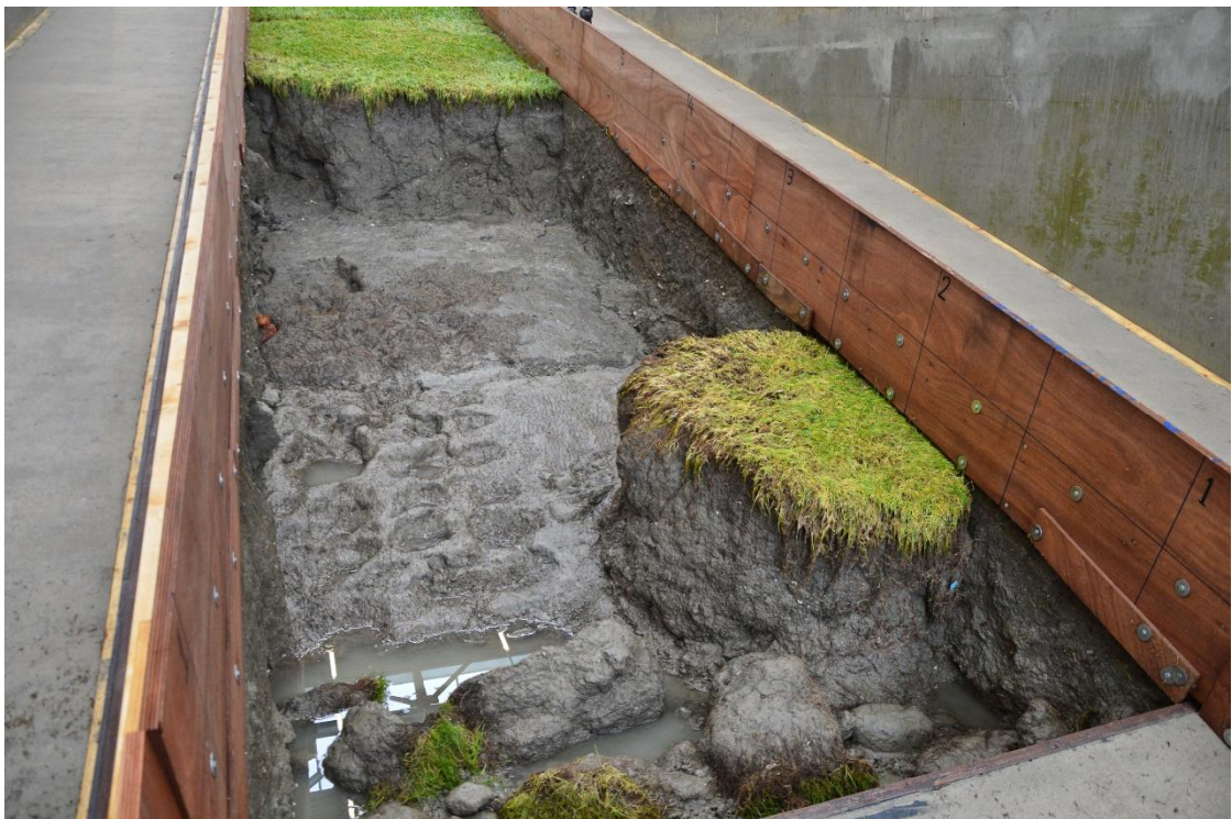
Fig. B-44 Erosiekuil na proef K1_11
