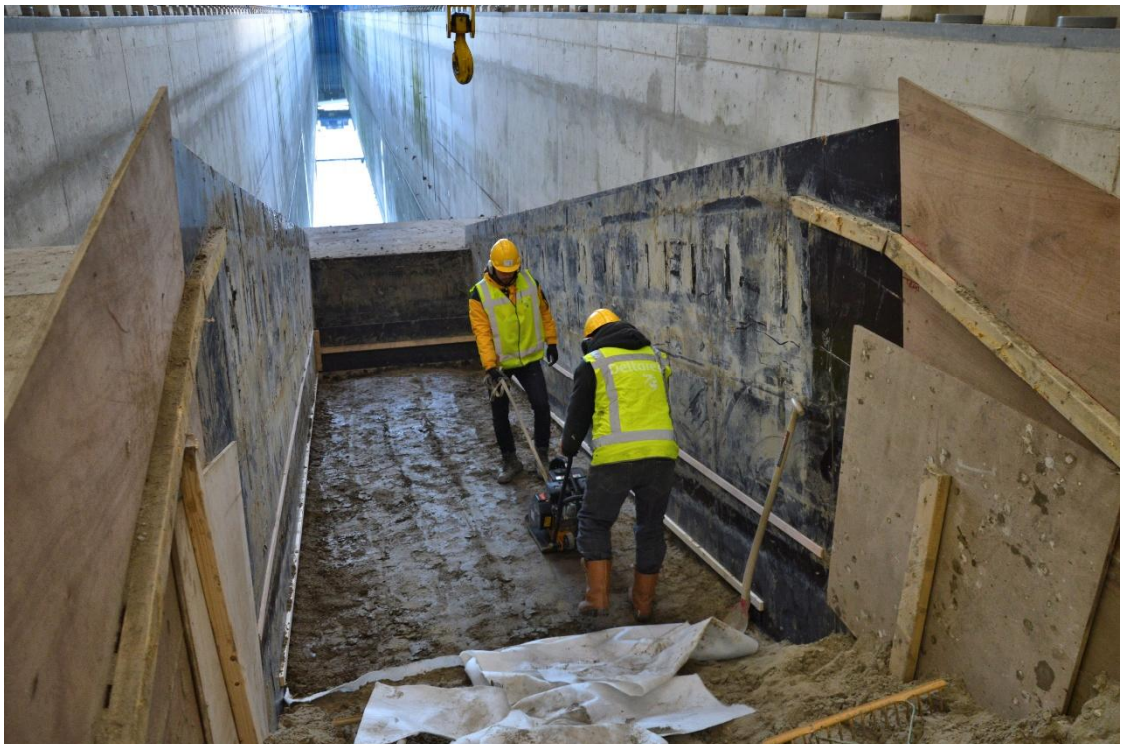
Fig. B-116 Kleilaag van geroerde klei aantrillen onder de kleiblokken
