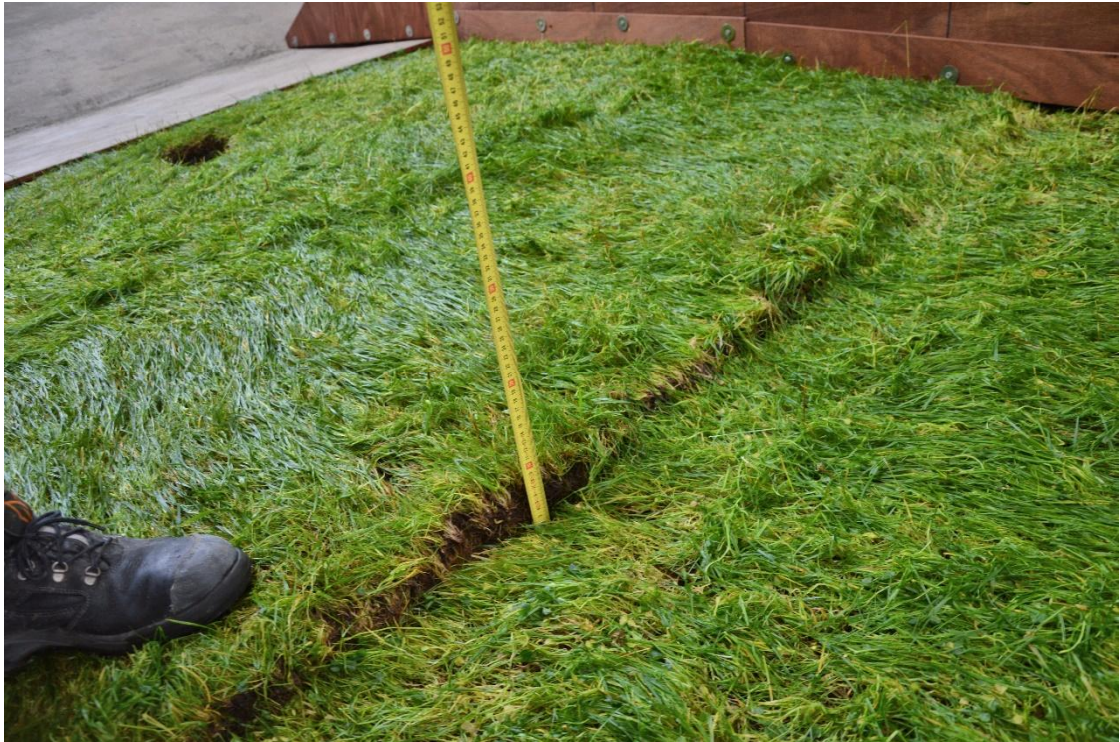
Fig. B-29 De aansluiting tussen eerste en tweede blok is niet helemaal vlak
