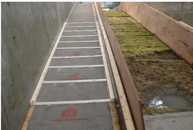
Figuur 4.11 Versterking van het houten schot door middel van een balk en verbinding naar de gootwand met latten
