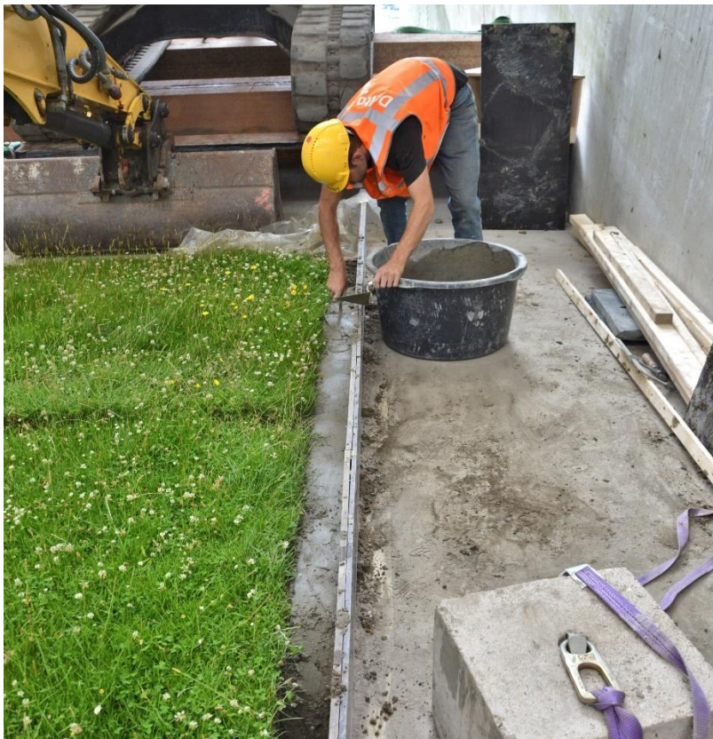
Fig. B-20 Zandcement aanbrengen in de spleet tussen de kleiblokken en de zijwand
