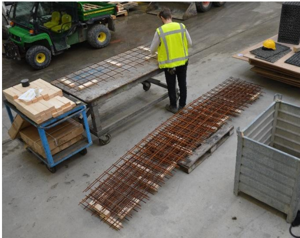
Fig. B-15 Wapeningsstaal voorbereiden en aanbrengen tussen de kleiblokken en de zijwand
