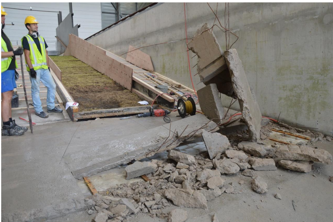
Fig. B-72 Verwijderen van de bermverhoging
