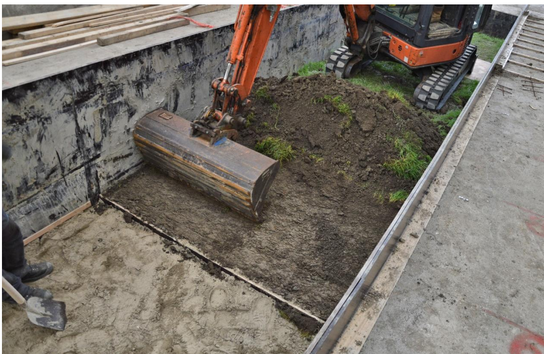
Fig. B-88 Verwijderen gras van de onderste laag kleiblokken
