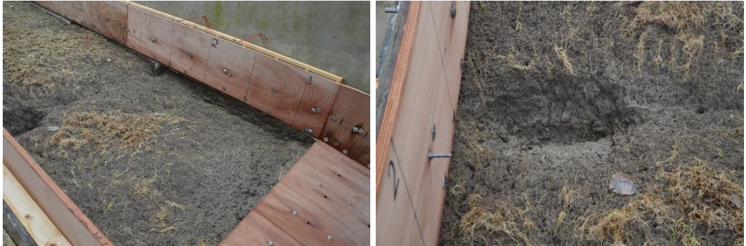
Figuur 3.17 Lokaal erosiegat na proef K2_06 ter plaatse van de aansluiting van het eerste en tweede kleiblok.
