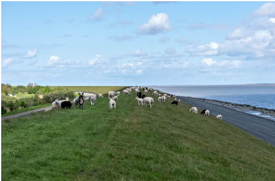
Figuur 1.1 Dijkbekleding van gras op een kleilaag op de dijk Lauwersmeerdijk-Vierhuizergat
