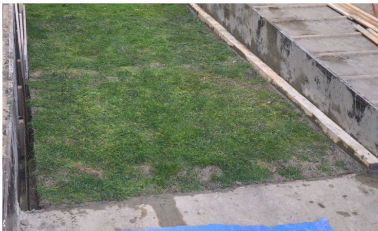
Figuur 5.8 Onderste deel van het grastalud dat een hete droge zomer heeft doorgemaakt en daarna ruim twee maanden water heeft gekregen tijdens een normaal najaar
