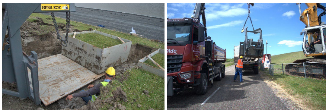
Figuur 3.2 Staalplaat eronder drukken en vervolgens in de vrachtwagen laden
