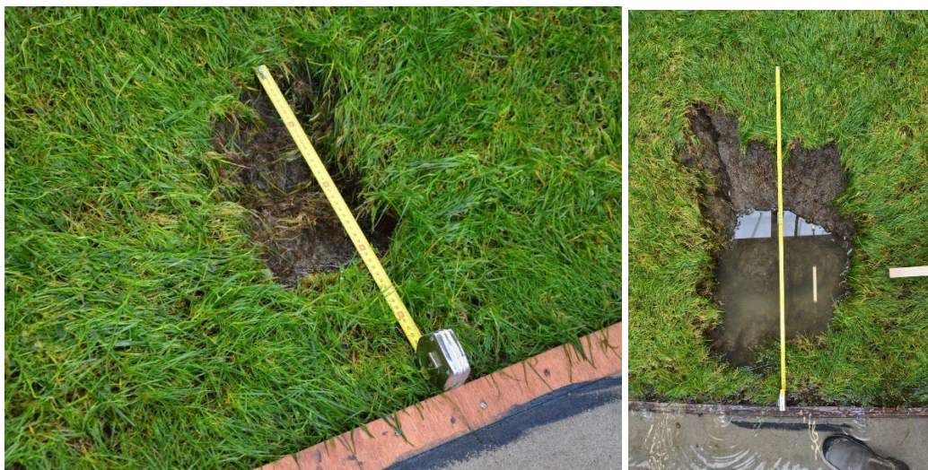
Figuur 5.1 Erosie van het gras. Situatie na proef K1_04 (links) en na proef K1_05 (rechts)
