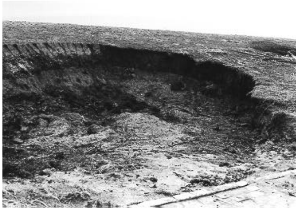
Fig. H-3 Schade bij km1,85
