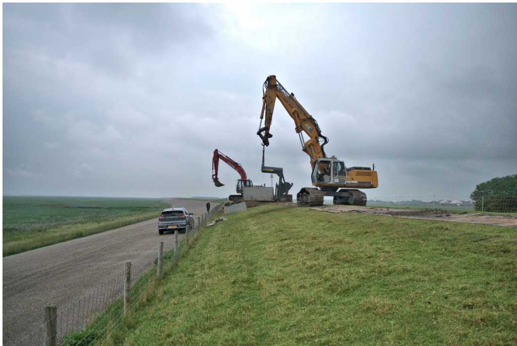
Figuur 2.2 Kleiblokken met gras steken op de dijk bij Holwerd
