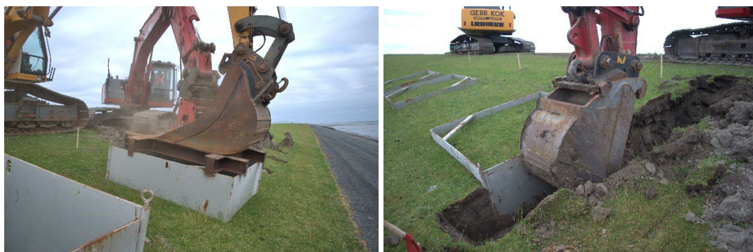
Figuur 3.1 Stalen mal in taludoppervlak drukken en vervolgens rondom vrijgaven
