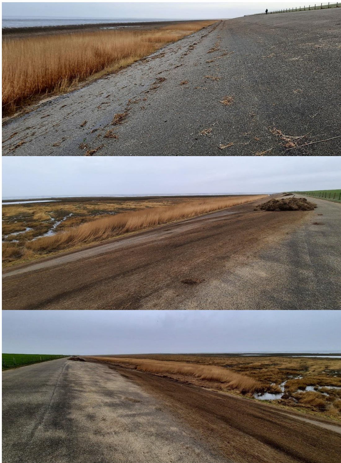
Figuur 4.6 Rechtopstaande vegetatie (vermoedelijk Phragmites (riet) en Elymus (zeekweek)) na drielingstorm Dudley, Eunice en Franklin februari 2022.
