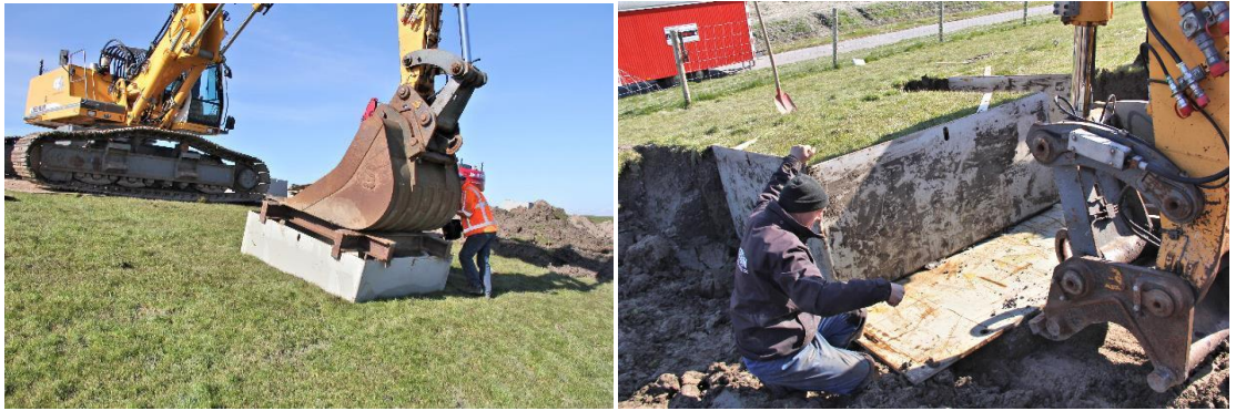
Figuur 8.3, Stalen bak zonder bodem wordt in de grond gedrukt (links) en na het rondom weggraven van de grond wordt een stalen bodemplaat eronder geschoven (rechts)
