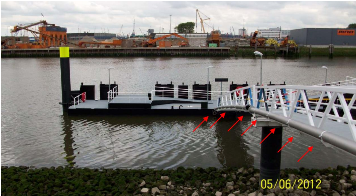
Figuur 2 Innamepunt TEO Port City. Het RVS leidingwerk moest twee jaar na aanleg vervangen worden (rode pijlen)
