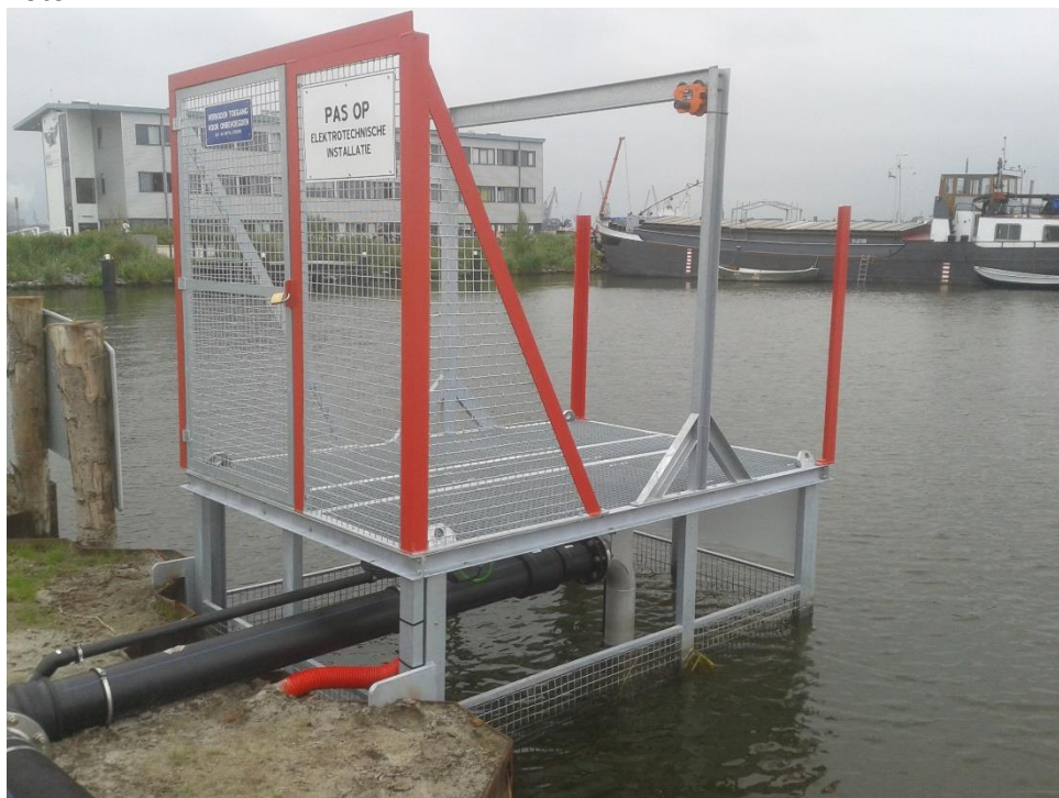
Figuur 1 | Tijdelijke inlaatconstructie in aanbouw (systeem 1 / 2). Nog in afwachting op een definitieve locatie aan de kade.
