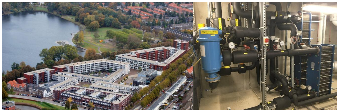
Figuur 4 | Projectlocatie met oppervlaktewater (IJzeren vrouw) en de aangesloten appartementen (links) en technische ruimte met filter en warmtewisselaars (rechts)
