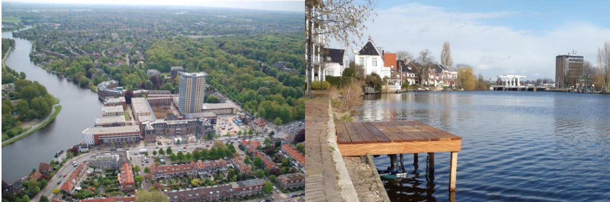
Figuur 5 | Projectlocatie aan de Spaarne (links) en de inlaatconstructie met aanzuigkorf (rechts)
