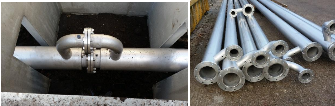
Figuur 4.5 Persleidingrioolwarmtewisselaar extern prefab, waarbij een dubbelwandige buis zorgt voor de warmteoverdracht
