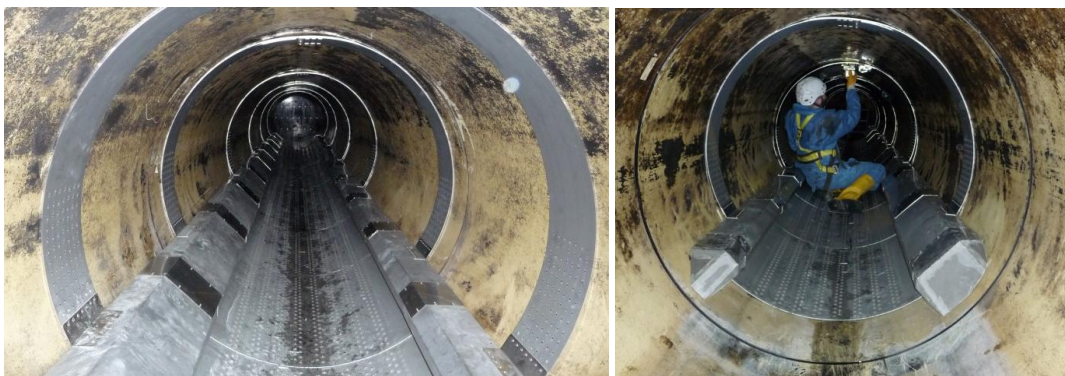
Figuur 4.1 Vrijvervalrioelwarmtewisselaar intern, deze wordt in schaaldelen ingebouwd (bron: Uhrig.com)
