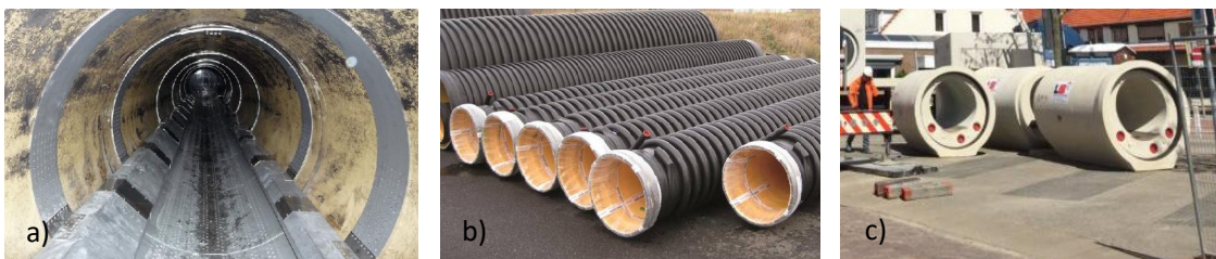
Figuur 9: Gesloten warmtewisselaar die worden toegepast bij TEA. a) schaaldelen in riool (bron: Uhrig), b) buis om rioolbuis (bron: Frank GHMB), c) rioolbuis met interne warmtewisselaar (bron: KD International B.V. - Rabtherm Energy Systems)
