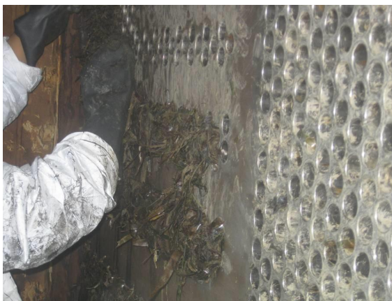
Figuur 11: Foto van vervuiling in een buizenwarmtewisselaar van een industriële toepassing
