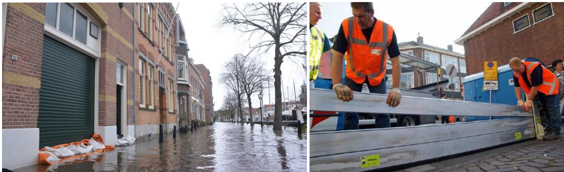
Figuur 2.2 Hoogwater met water op de kades in het buitendijkse gebied en zandzakken om schade te voorkomen (links) en rechts de jaarlijkse vloedschotten-test ter voorbereiding op hoogwaters
