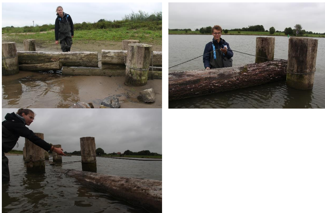
Figuur F.2 Loszittende staalkabels bij scherm 2 (onder, 5698) en scherm 3 (boven, 5688, 5693).
