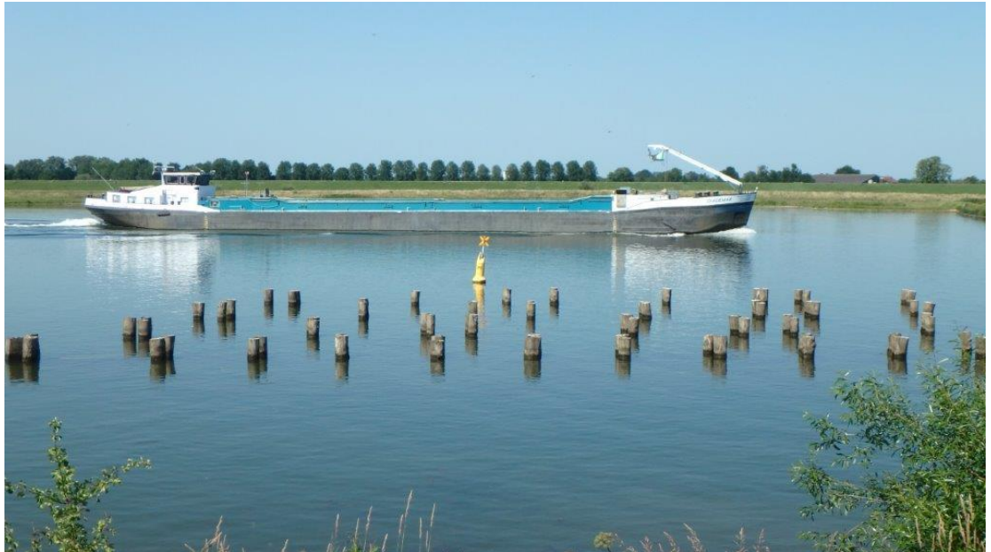
Figuur 1.6 De houten schermen in de Lek bij de Redichemse waard nabij Culemborg kort na realisatie in 2015 (foto Kees Sloff, 2020).
