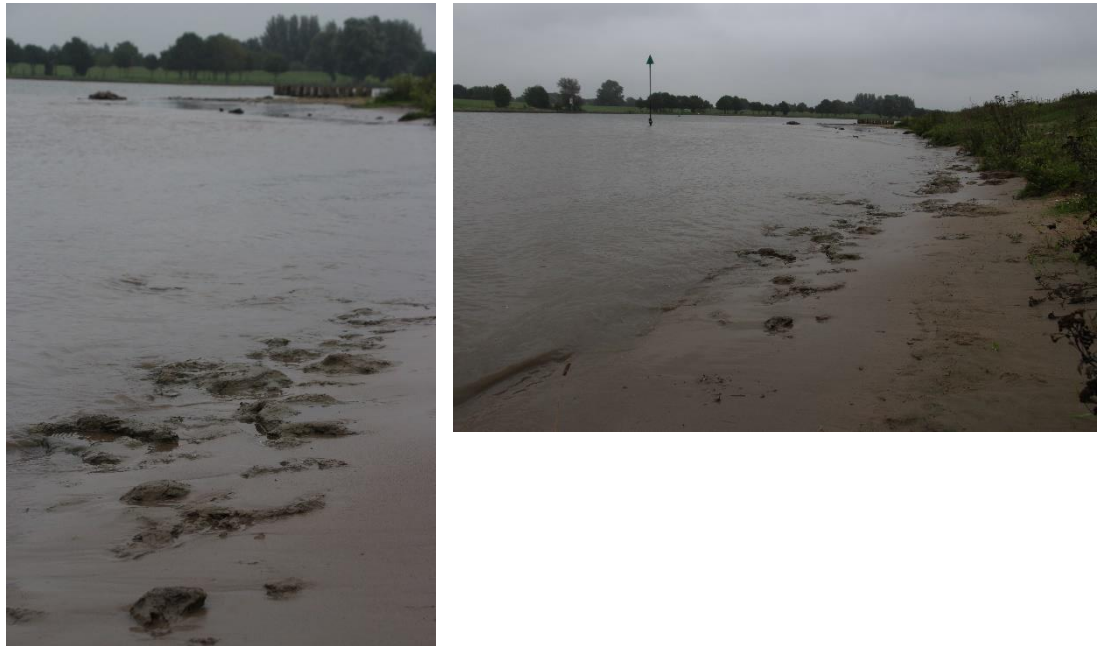
Figuur 5.6 Erosiebestendig materiaal steekt boven het zand uit.
