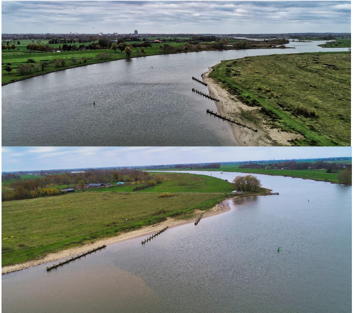
Figuur 1.5 Luchtfoto's van de houten schermen gezien in bovenstroomse richting (boven) en in benedenstroomse richting (onder met van links naar rechts scherm 1, 2 en 3); Foto's Han Schenk, Rijkswaterstaat, november 2020.
