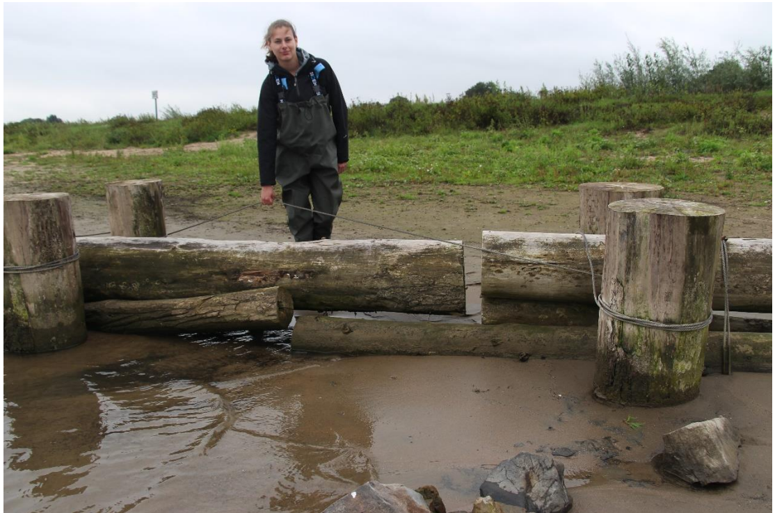
Figuur 3.7 Een deel van houten scherm 3, waarbij kieren tussen de stammen zichtbaar zijn.
