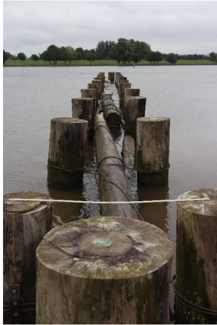
Figuur 5.8 Verzakking scherm 2.
