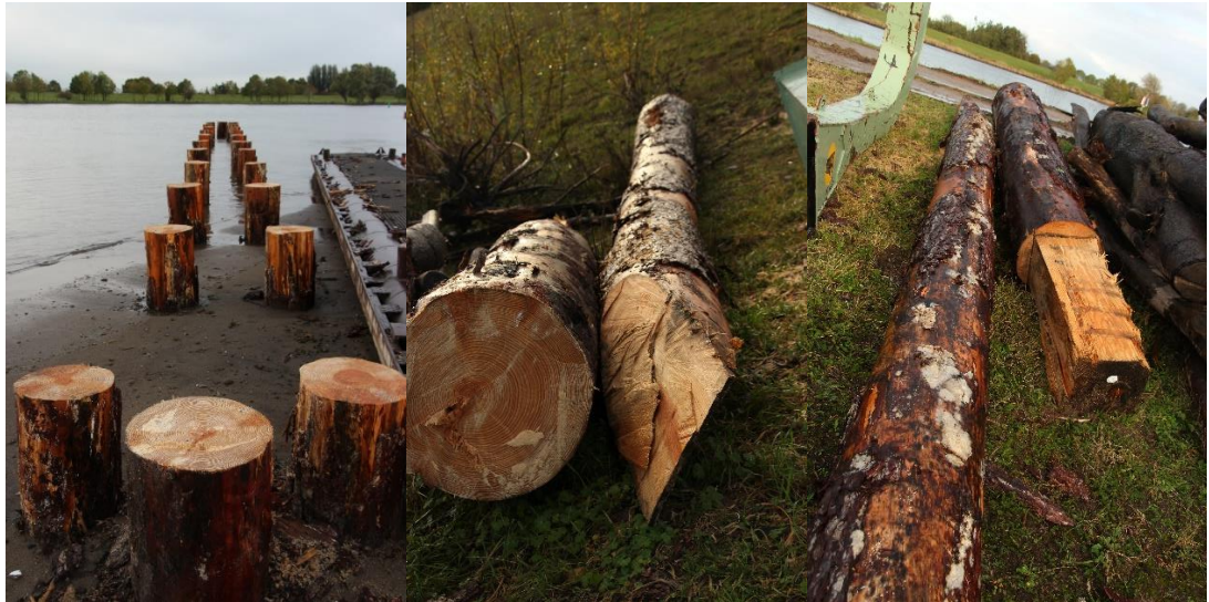
Figuur 3.5 De staanders voor houten scherm 2 (links), de punt onderaan de staander (midden) en de bovenkant waar het trilblok aan bevestigd werd (rechts); Foto's Frans Buschman 13 november 2019.
