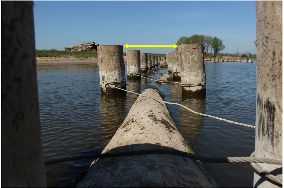
Figuur 3.6 De bovenste houtlaag is geborgd met staaldraad; de gele pijl geeft de bepaalde afstand tussen de standers aan.
