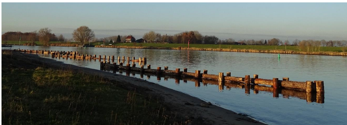
Figuur 3.1 De gerealiseerde drie houten schermen (foto BAM / Van den Herik, December 2019). In de voorgrond scherm 1, daarachter scherm 2 en in de achtergrond scherm 3.
