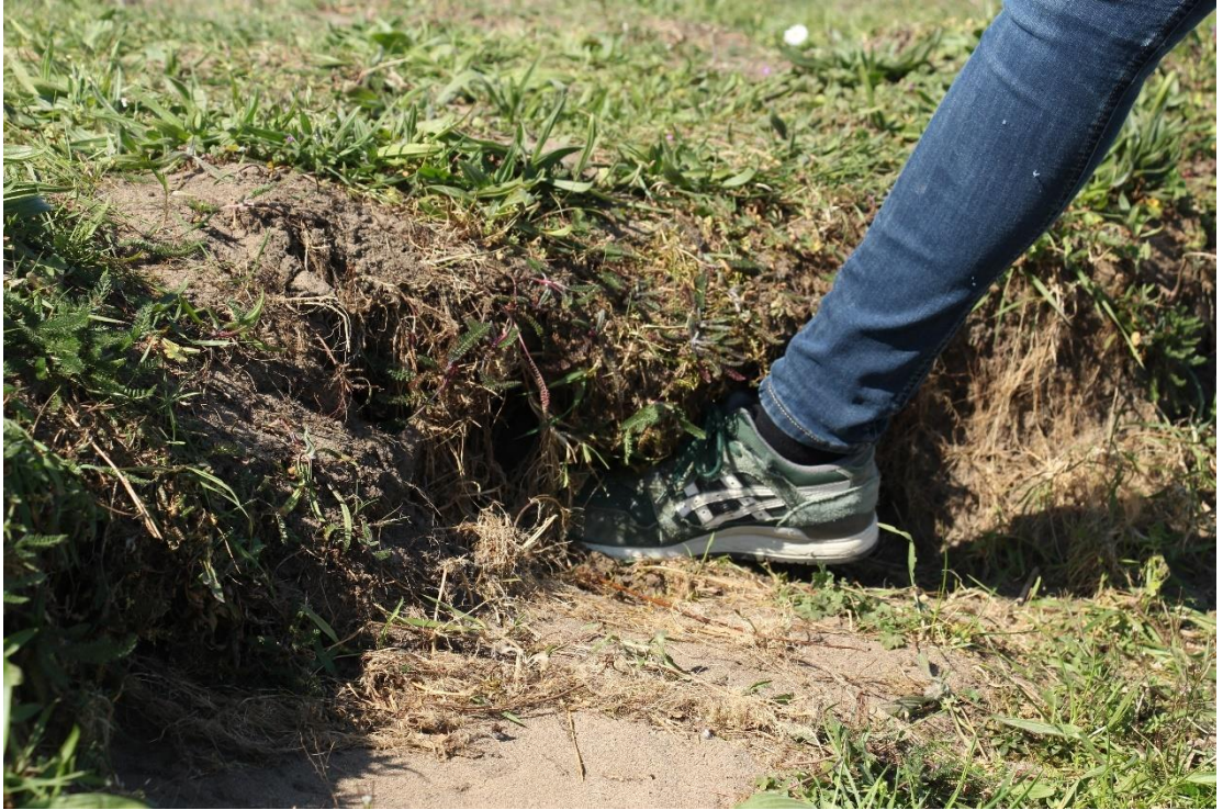
Figuur 5.2 Ondergraving van de toplaag.
