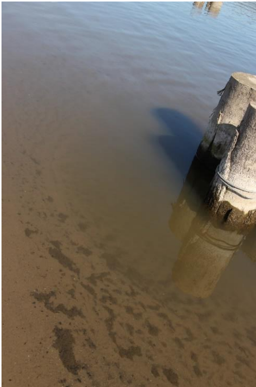
Figuur 4.13 Lokale ontgraving rond de staanders.
