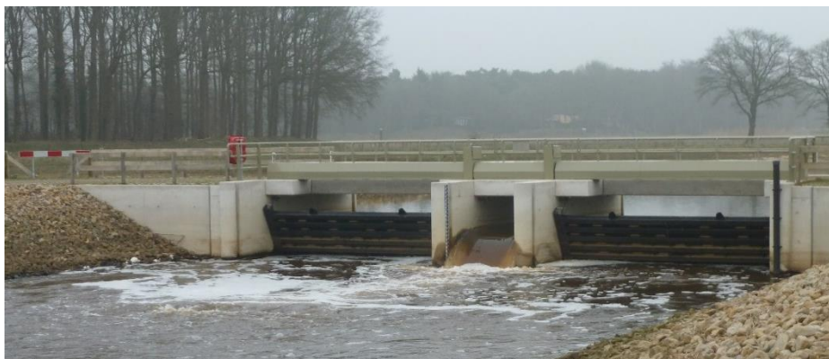
Figuur 2.14 Stuw Plaggenmars (inlaatwerk nevengeul Vilsteren).
