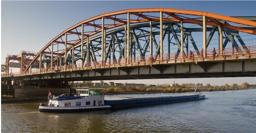
Figuur 1.2 Blik op de IJsselbrug in Zutphen, gezien vanaf de IJsselkade. Fotocredit https://beeldbank.rws.nl , Rijkswaterstaat / Harry van Reeken)
