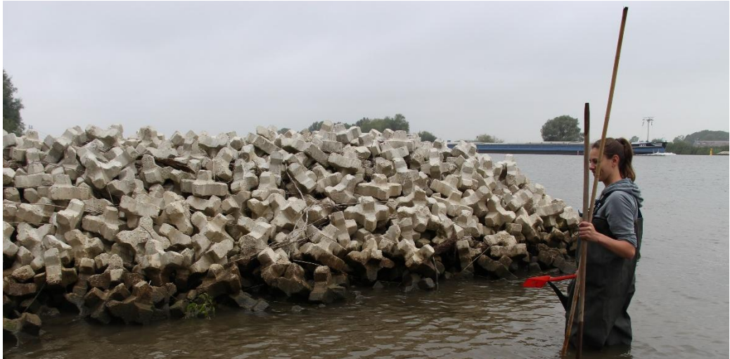
Figuur 2.1 Monitoring van de pilot flexibele kribben met X-streamblokken
