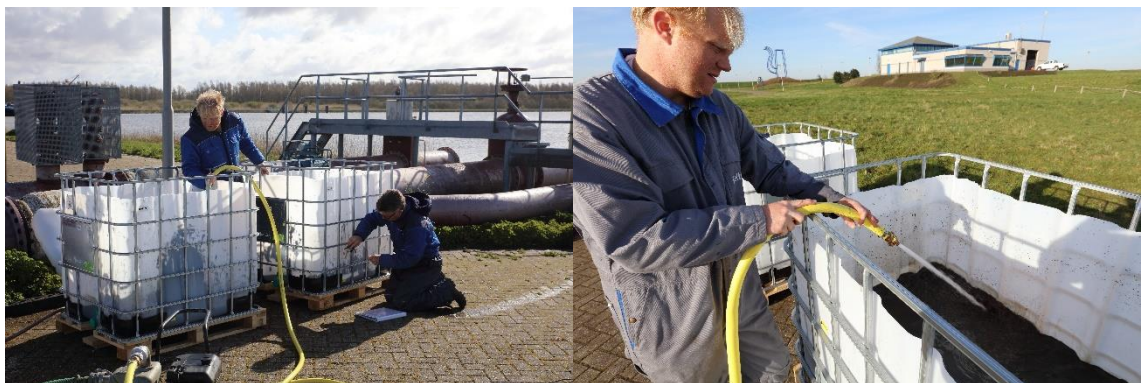
Figuur 7 Het roeren van de baggerspecie door middel van jetten
