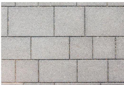
Figuur 2: Voorbeeld waterdoorlatende verharding (bron: Klostermann Beton).
