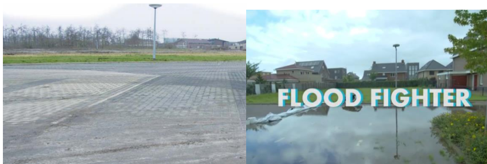
Figuur 6: Links: dichtgeslibde doorlatende verharding in Almere (bron: Rus M, presentatie RIONED) Rechts: Tests op volledige schaal van waterpasserende verharding (bron: TU Delft TV: https://www.youtube.com/watch?v=R14BajCwU6w ).
