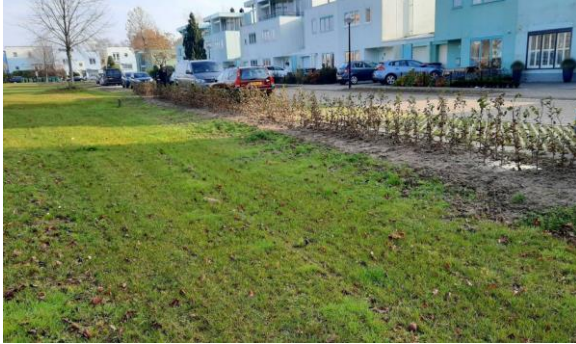
Figuur 10: Een voorbeeld van doorgroeibare verharding in de Aquamarijnstraat (Almere) met overloop naar de nabijgelegen berm in dit geval een wadi (bron: https://www.climatescan.nl/projects/5364/detail ).
