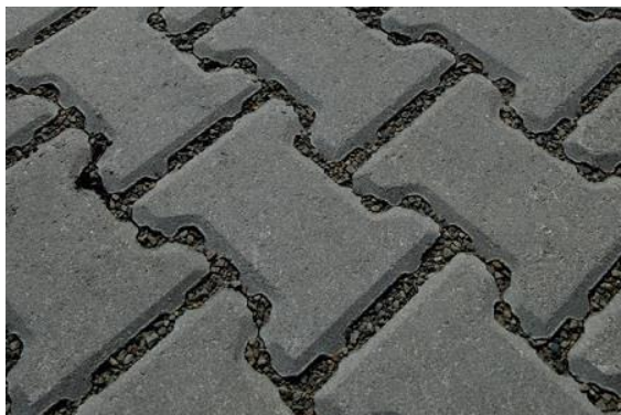
Figuur 1: Voorbeeld waterpasserende verharding (bron: StruykVerwo).
