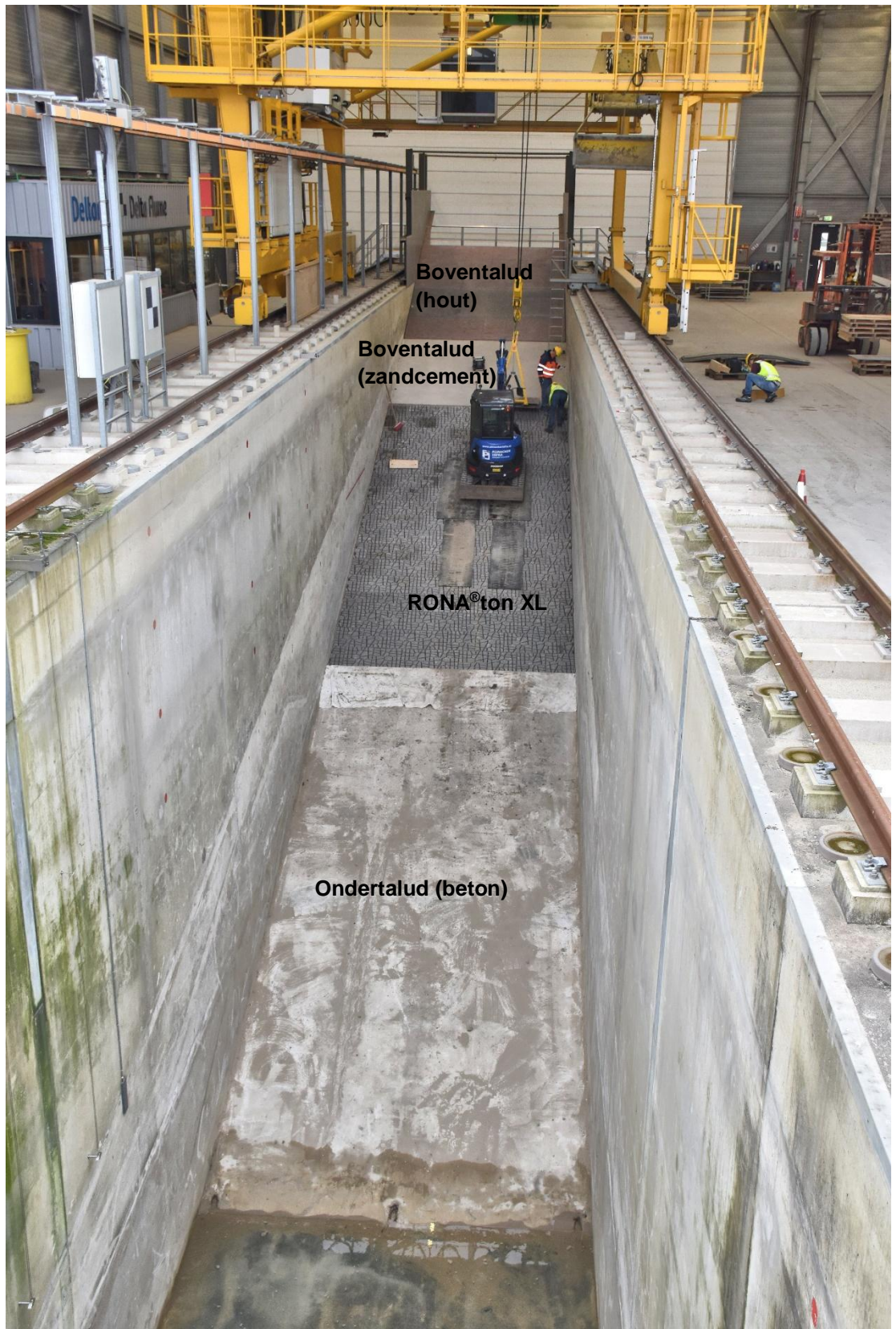
Fig. E-9, Overzicht van dijktaalud
