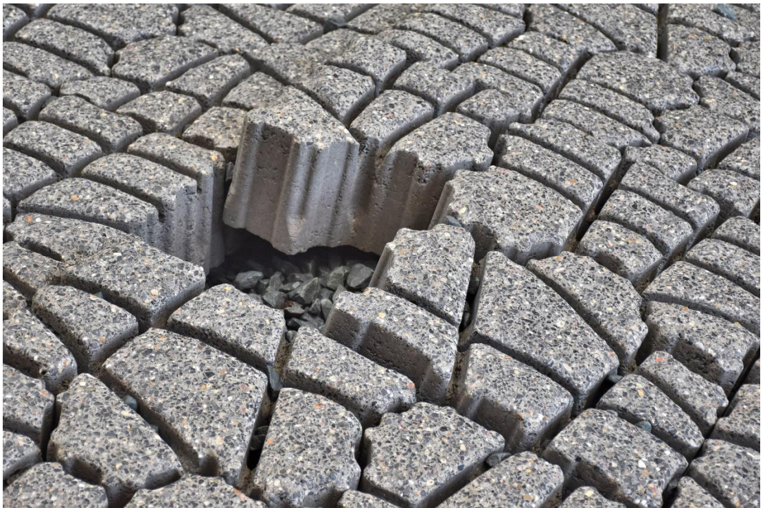
Fig. E-21, Schade na proef RXL-13
