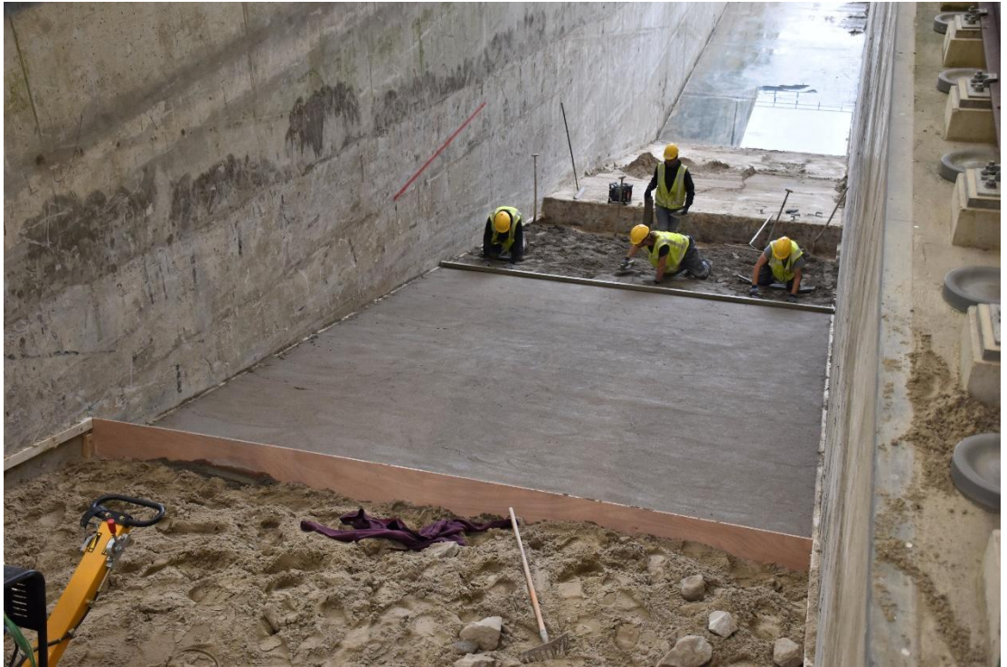
Fig. E-1 Aanbrengen zandcement in het vak waar later de steenzetting komt
