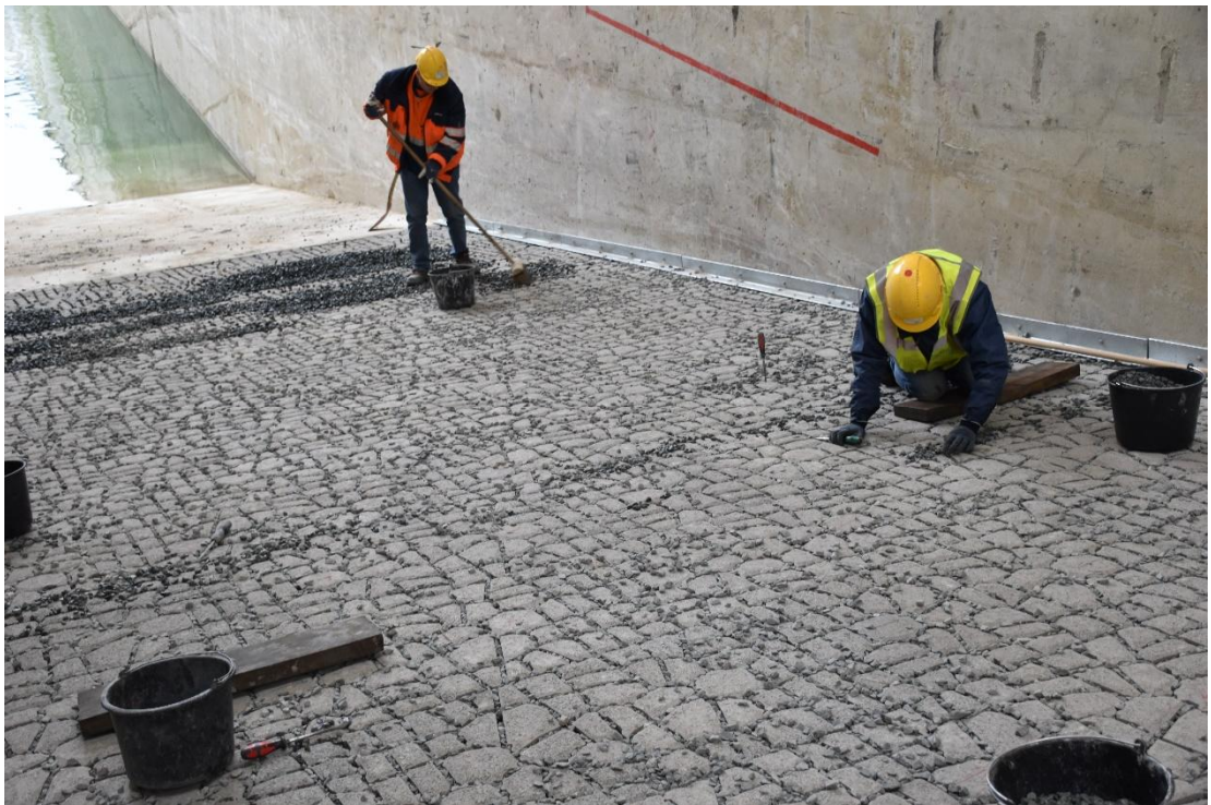
Fig. E-8, Inwassen van de steenzetting met steenslag
