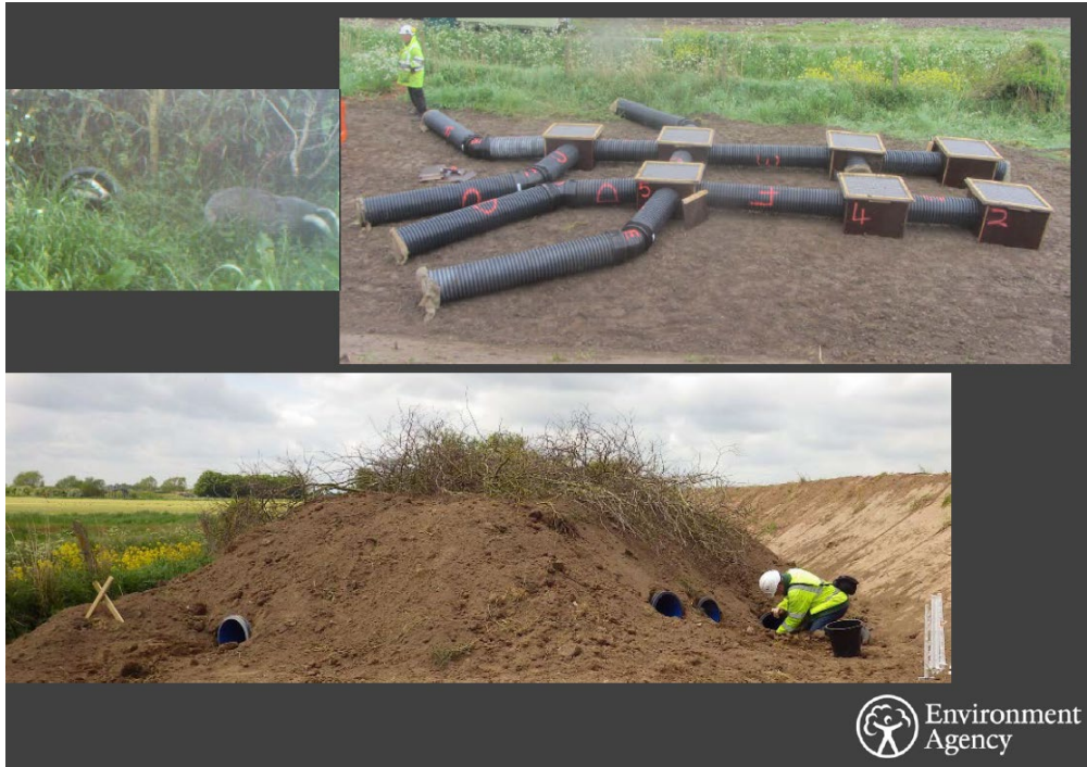
Figuur 10 Kunstmatige dassenburcht naast een waterkering [UKEA, 2021]
