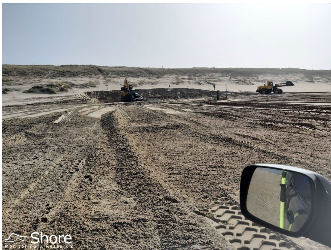
Figuur 2.5 Afgraven duinvoet t.b.v. plaatsing strandbebouwing.
