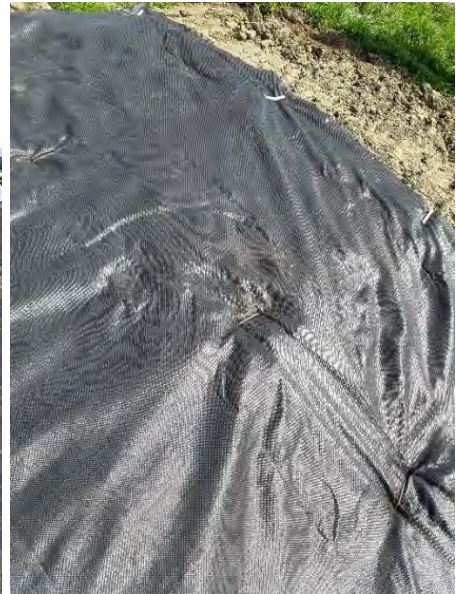
Figuur 20 plaatsen van twee panelen PE-filtratieweefsel en fixering met korte, gladde T-pennen en U-krammen. Deze bekramming wordt ook nog rechts van de Tensarbekramming aangebracht. Ook hier zitten de krammen volledig tegen het doek aan.
