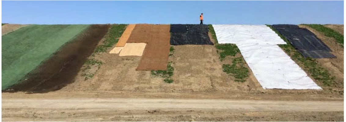
Figuur 4 Situatie op 31 maart 2021 na plaatsing van alle bekrammingen. Van links naar rechts: Turf mat met Gripple Terra-Lock ankers (klapankers) en Terra-Lock pinnen (niet binnen Wiki Noodmaatregelen aangelegd en beproefd); Joosten Ecomat K400, daaronder jutemat, daarnaast kokosmat (allemaal gefixeerd met houten pinnen); PE 180 mat, daaronder een veel water- en lichtdoorlatender Ten Cate Geleon® PE 60 mat, dan Tensar TriAx TX190L-G Geogrid en Ten Cate Geleon® PP 180 mat.
