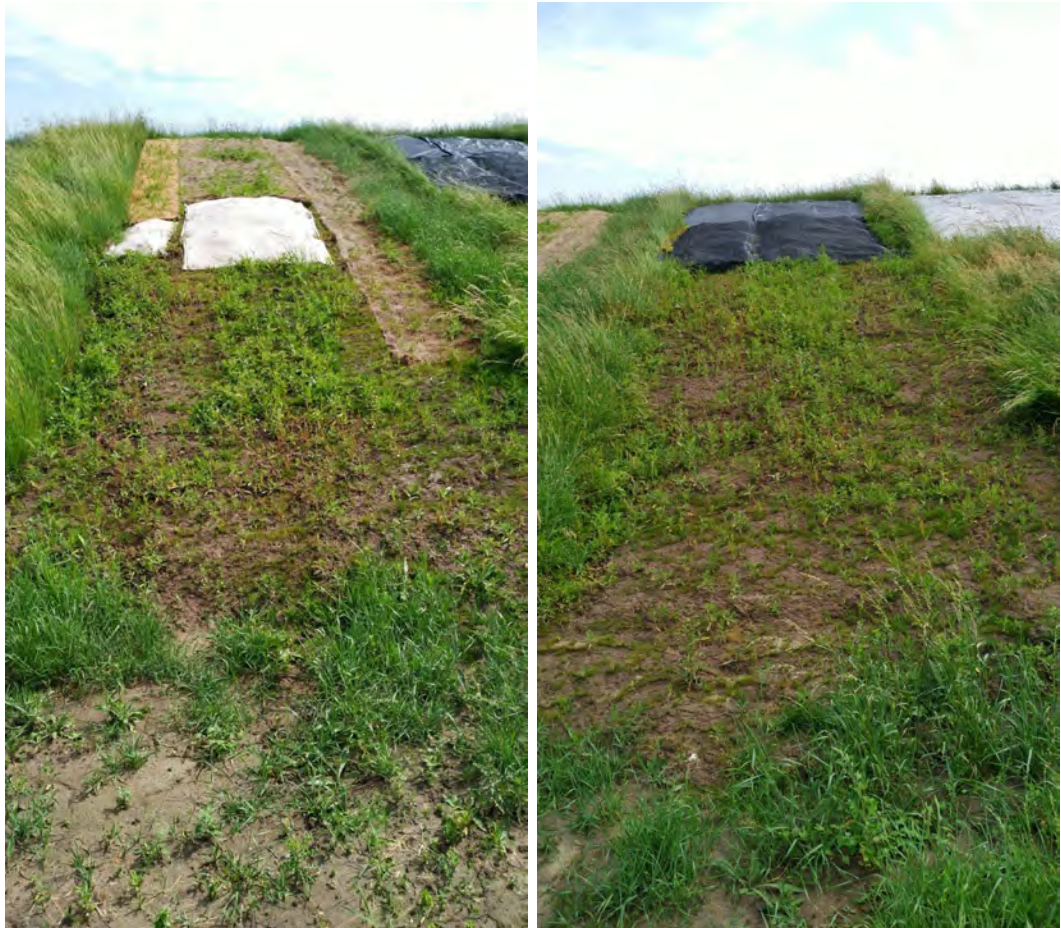
Figuur 24 links: zicht op de biologisch afbreekbare doeken en daaronder het oorspronkelijk kale kleivlak; rechts zicht op het PE- en daaronder het PP-doek en het oorspronkelijk kale kleivlak. De vegetatie is inmiddels ontwikkeld en groeit door de biologische matten heen. Alleen de PE-mat (helemaal bij de kruin) en het Tensardoek lijken nog vlak tegen het talud aan te liggen.
