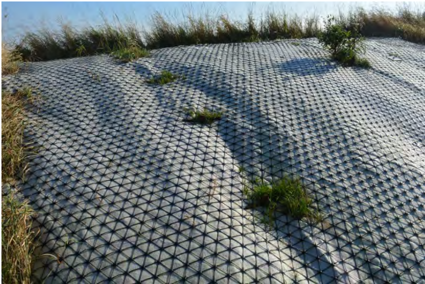
Figuur 44 Het Tensardoek wordt door de groeiende vegetatie onder het doek iets omhooggeduwd.
