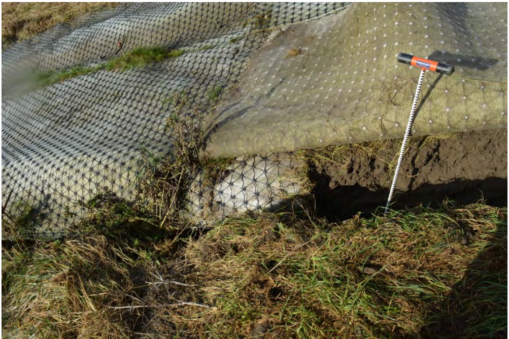
Figuur 75 Blik op gleuf bij overlap van de bekrammingsdoeken.
