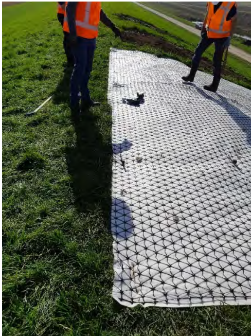
Figuur 11 Blik langs de kruin op Tensarbekramming. De krammen zitten met hun horizontale gedeelte direct op het doek met volledig contact tussen doek en pen.
