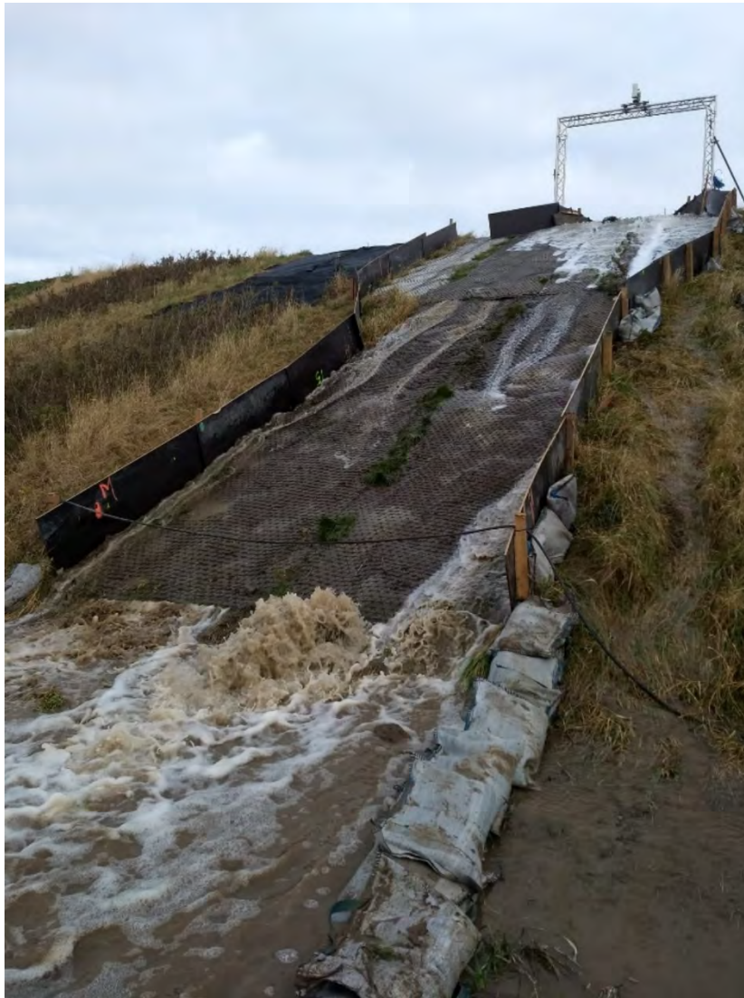
Figuur 55 Tensarbekramming tijdens overlooptest.
