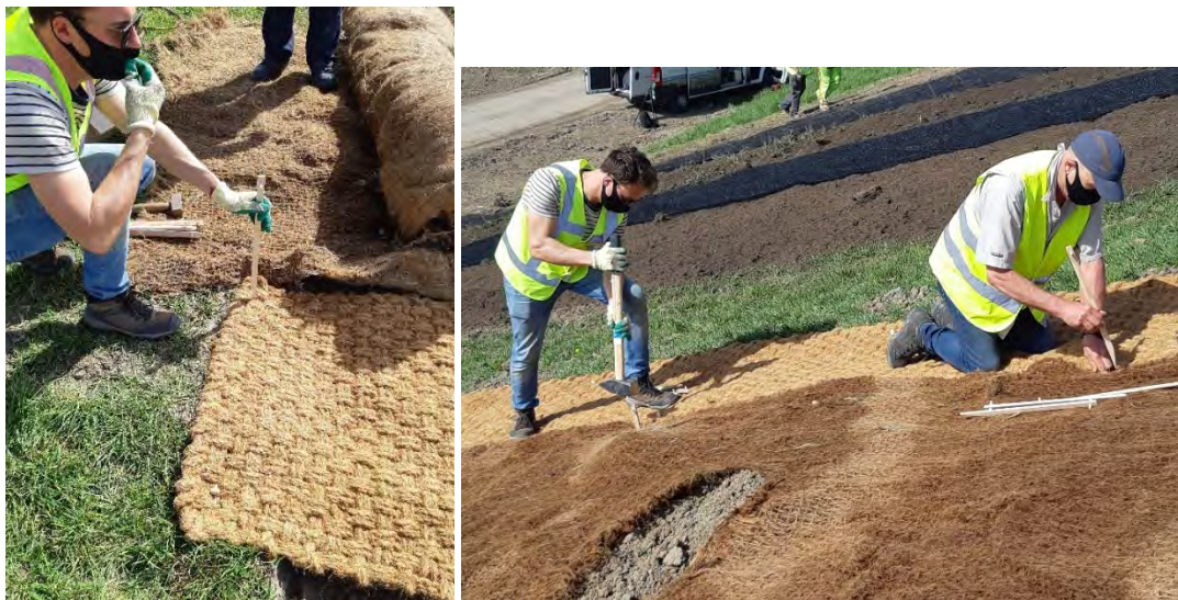
Figuur 18 De bio-afbreekbare doeken worden allemaal met bio-afbreekbare pennen vastgezet. Het horizontale gedeelte van deze pennen is relatief kort, maar geeft een goed contact met het doek.
