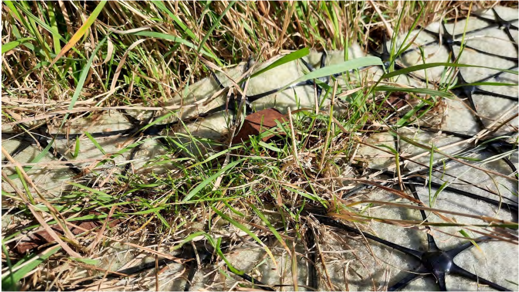
Figuur 45 De ijzeren Y-krammen zitten nog steeds vast op het doek. Daar waar de kram het doek heeft geperforeerd groeien grassprietten eruit.
