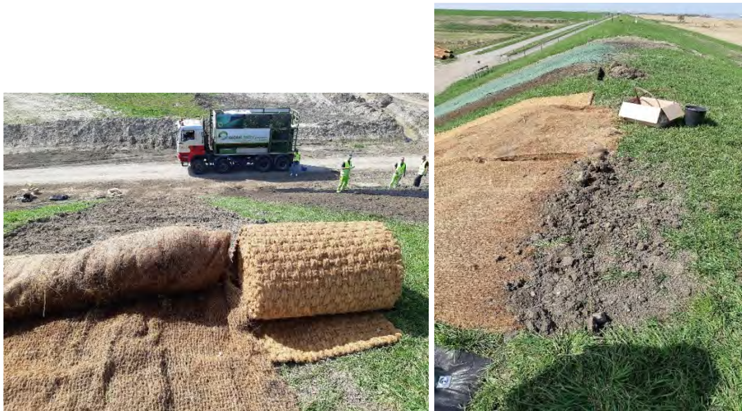
Figuur 17 Plaatsen van de kokosmat (links) en de Ecomat (rechts) vanaf de kruin. Op de kruin is de graszode nog intact. Een bovenrand van een deel van de kokosmat is in de kruin ingegraven.
