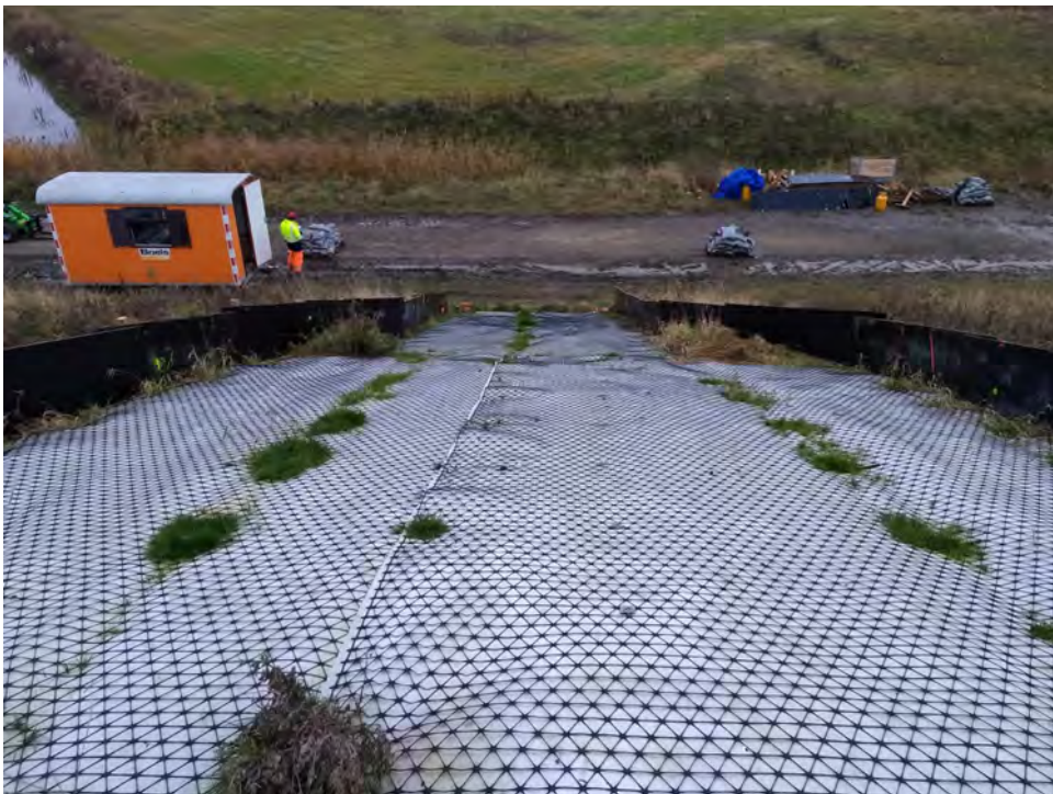
Figuur 54 Om het bekrammingsdoek niet te beschadigen worden de houten schotten, die het overstromende water zullen begrenzen, direct langs de randen van het doek in de grond gezet. Omdat bij de dijkteen maar één Tensardoek geplaatst is, vormen de schotten aan de onderkant een vernauwing van de stroming.
