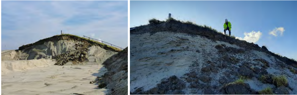
Figuur 53 De te beproeven dijk bestaat uit een grote zandkern die alleen door een circa 1 m dikke kleilaag tegen erosie beschermd wordt. De dikte van deze kleilaag is zeer wisselend.
