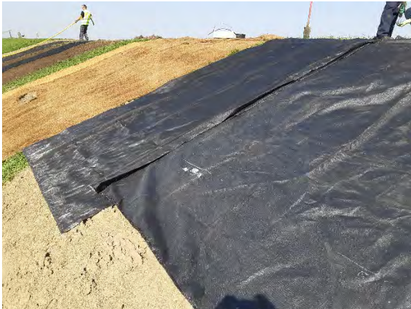
Figuur 20 plaatsen van twee panelen PE-filtratieweefsel en fixering met korte, gladde T-pennen en U-krammen. Deze bekramming wordt ook nog rechts van de Tensarbekramming aangebracht. Ook hier zitten de krammen volledig tegen het doek aan.
