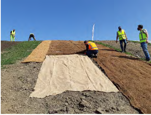
Figuur 19 Onderaan de kokosmat wordt een jute mat geplaatst. Tussen de bio-afbreekbare doeken wordt geen overlap gecreëerd omdat deze bekrammingen later niet zullen worden getest met overloop.
