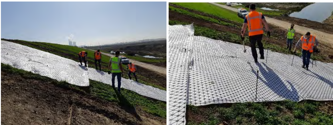
Figuur 13 Het derde Tensardoek wordt met 1 m overlap onder het daarboven liggende doek met een Y-pen gefixeerd en daarna naar de teen toe afgerold (links). Daarna wordt het doek met dezelfde typen krammen als in de rij daarboven vastgezet. Alleen een klein deel van het doek zit hier op de intacte zode. Het merendeel van het doek bedekt de vers ingezaaide, niet-verdichte kleigrond.
