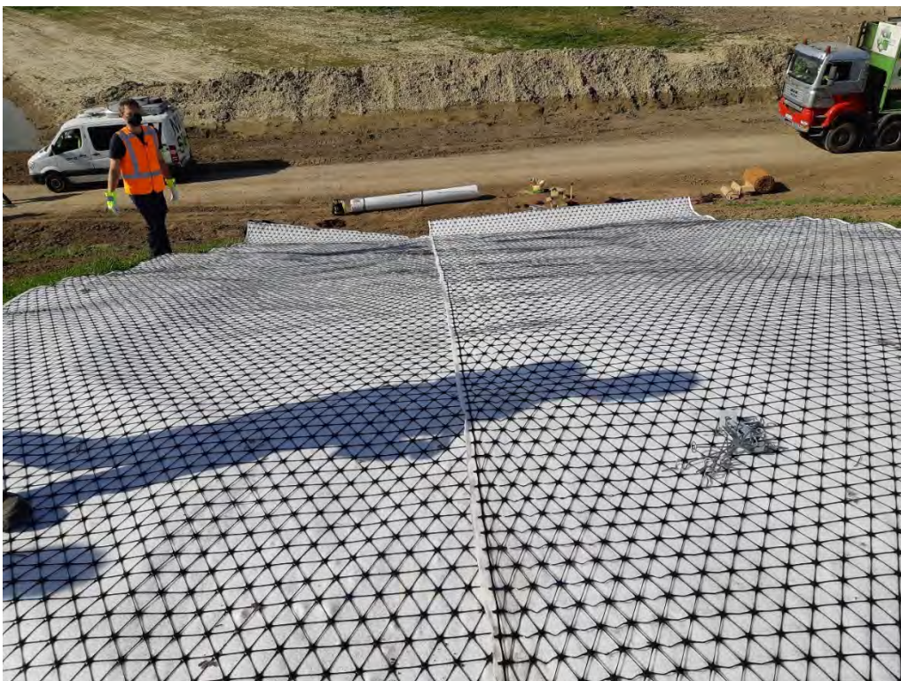
Figuur 9 De tweede baan doek wordt direct daarna met circa 1 m overlap geplaatst en afgerold.
