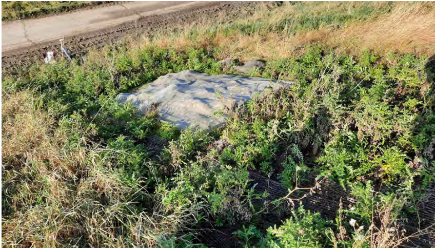
Figuur 33 De jutemat is grotendeels door de vegetatie onder het doek omhooggetild.
