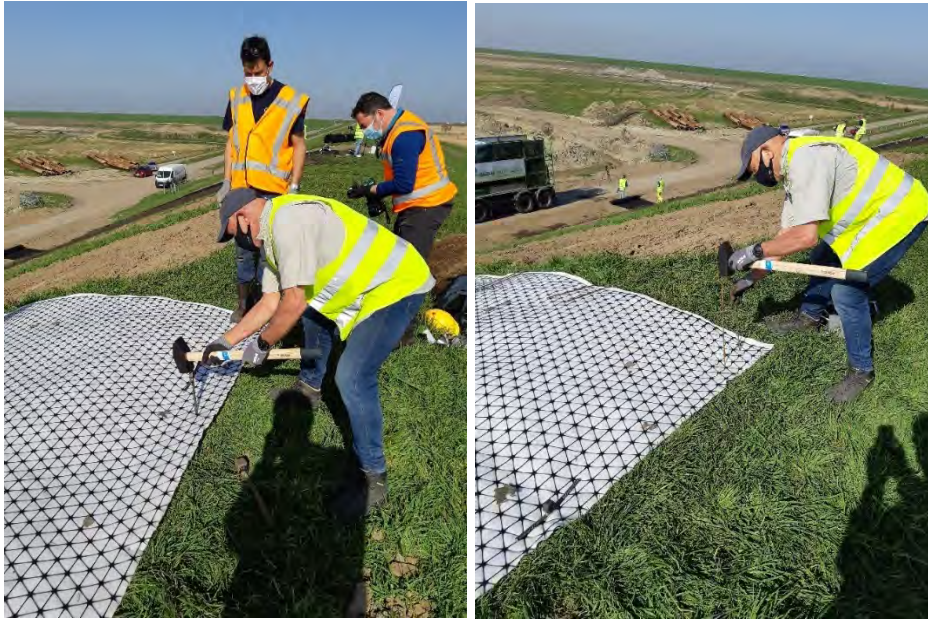
Figuur 10 Na het plaatsen van de twee banen wordt het Tensardoek aan de kruin van de dijk met andere typen krammen vastgezet. Links met een lange ijzeren Y-kram, rechts met een U-kram. De stijve Y-pen is snel en makkelijk met een voorhamer in de grond te krijgen. De staafdikte van de U-kram is relatief dun, waardoor de kram minder stijf is en daardoor bij het inslaan met de voorhamer makkelijk vervormt en minder snel in de grond te slaan is.
