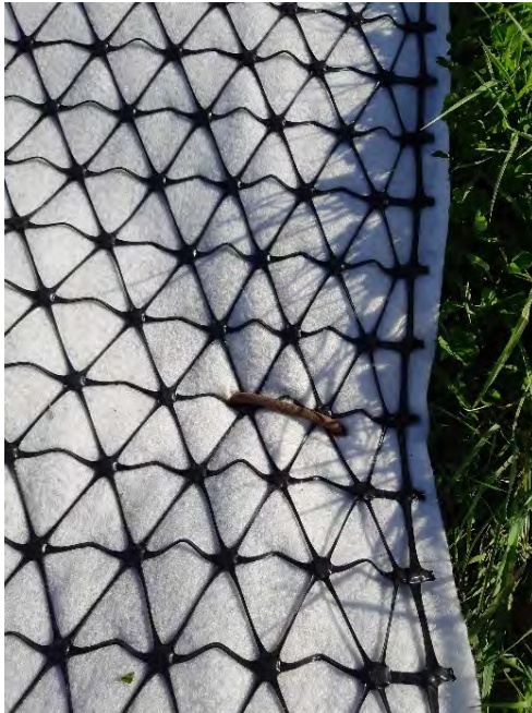
Figuur 14 U-kram zit volledig op het grid van het doek.
