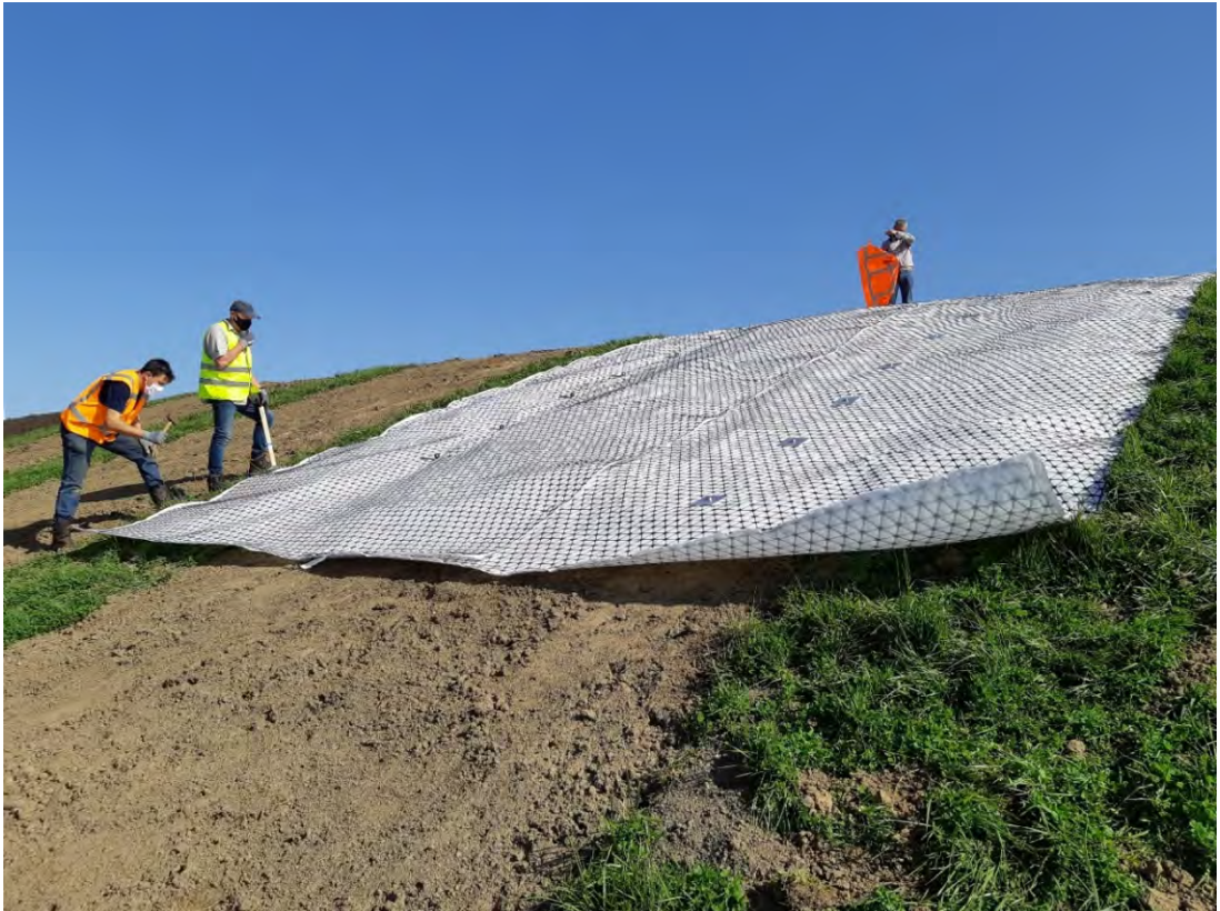
Figuur 12 Vanaf de kruin naar de teen toe wordt het doek met dezelfde type kram per rij vastgezet, in totaal 5 rijen met verschillende types krammen. De onderste meter van het doek wordt nog niet vastgezet, zodat het volgende doek nog met overlap onder de al geplaatste bekramming kan worden gelegd.
