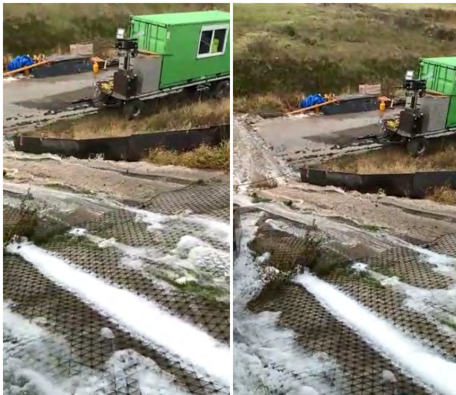
Figuur 57 Behalve de stroming langs de schot is ook een tweede stroom water circa 1 m daarnaast op de bekramming te zien. Aan de rechterkant stroomt het merendeel van het water onder de overlap met het bovengelegen doek weer uit en stroomt dan verder over het Tensardoek heen naar de weg toe.
