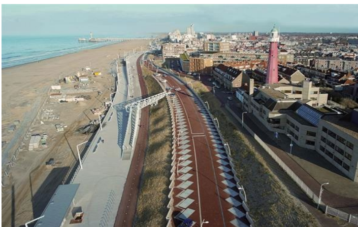
Figuur 4.6 - Kustversterking Zwakke Schakel Scheveningen. Dijk-in-boulevard. Bron: https://beeldbank.rws.nl , Rijkswaterstaat / Harry van Reeken.
