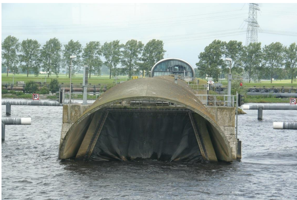
Figuur 4 Zicht op het middenlandhoofd in de Ramsgeul vanaf het bedieningsgebouw aan de zuidkant, 5-7-2016 (foto: Dénes Beyer)
