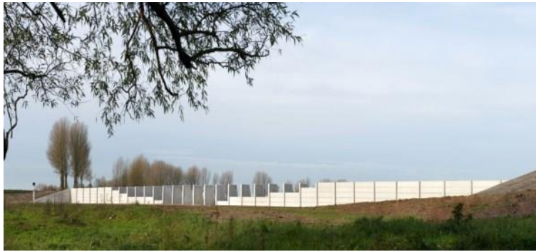
Figuur 2.7 Regelwerk Pannerden (bron: www.rijnwaardenseuiterwaarden.nl ).
