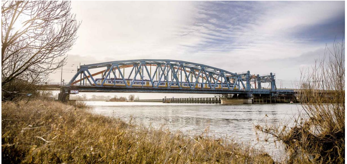
Figuur 2.13 Spoorbrug bij Zutphen (IJssel rkm 928).
