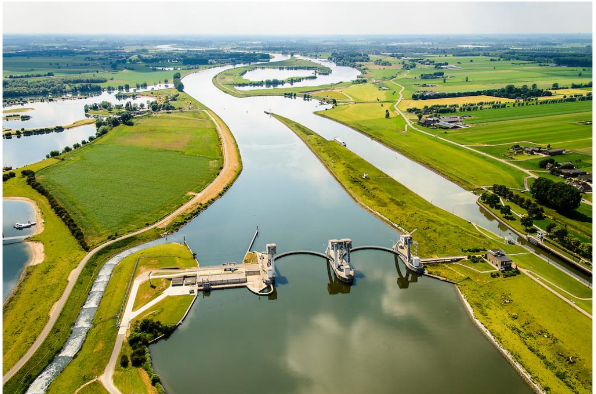
Figuur 2.6 Overzichtsfoto van het stuwcomplex Amerongen in benedenstroomse richting, met links direct naast de vizierschuiven de WKC Amerongen en meest links de vistrap (bron: wikimapia.org)
