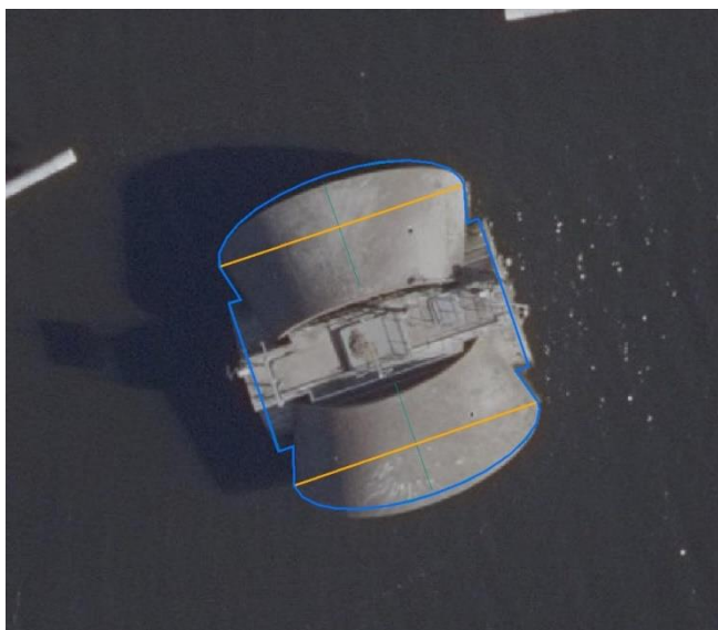
Figuur 7 Twee opties voor de waterlijn op basis van het DTB en daarmee voor de balglengte: in blauw het DTB (dak), in oranje een aangepaste begrenzing in overeenstemming met figuur 6. Onder detail van het middenlandhoofd.
