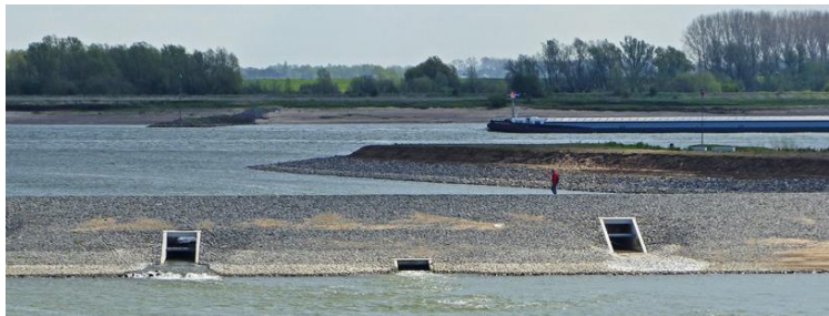
Figuur 2.14 Duikers in inlaatwerk bij de hoogwatergeul bij Veur-Lent (bron: www.nijmegency.nl ).
