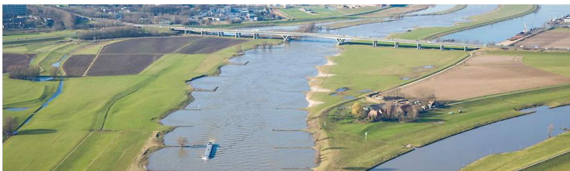
Figuur 2.12 Brug N325 (Andrej Sacharovbrug) bij Arnhem (Neder-Rijn rkm 880).
