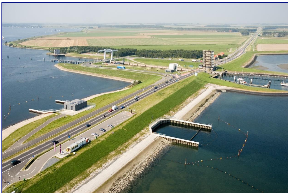
Figuur 4-7 Doorlaatmiddel Katse Heule en op de achtergrond de Zandkreeksluis (sluis Kats) (bron: Beeldbank RWS)
