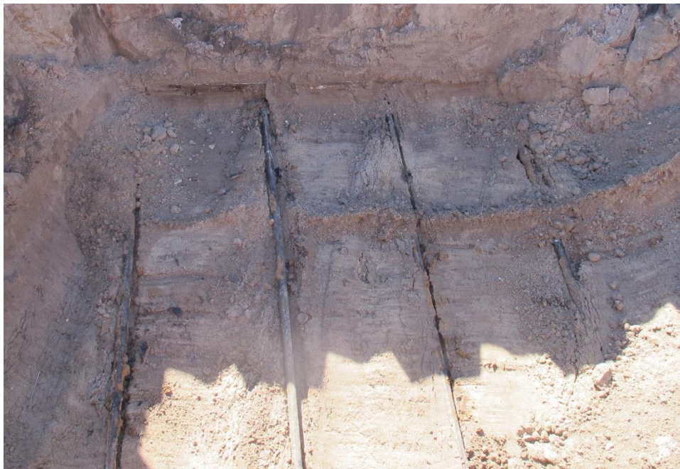
Figuur A.6 Anker 1 t/m 4 gezien richting de damwand.
