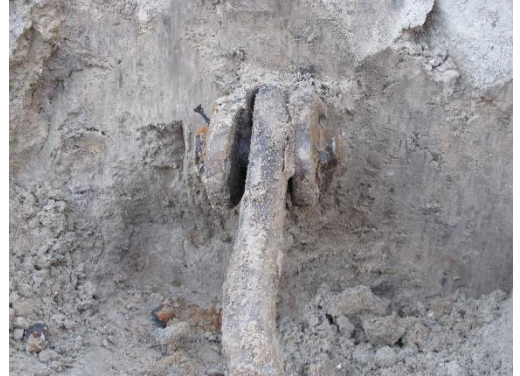
Figuur A.2 Oogverbinding met ankerwand (zijaanzicht links, bovenaanzicht rechts).
