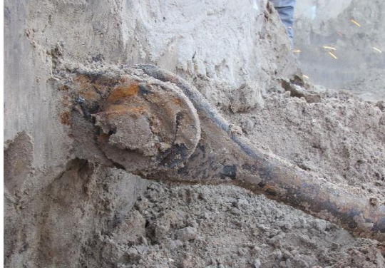
Figuur A.2 Oogverbinding met ankerwand (zijaanzicht links, bovenaanzicht rechts).
