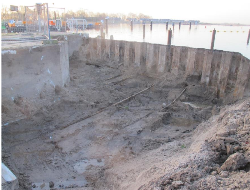
Figuur 6.1 Overzicht met ankerstangen Binnenhoofd-west.
