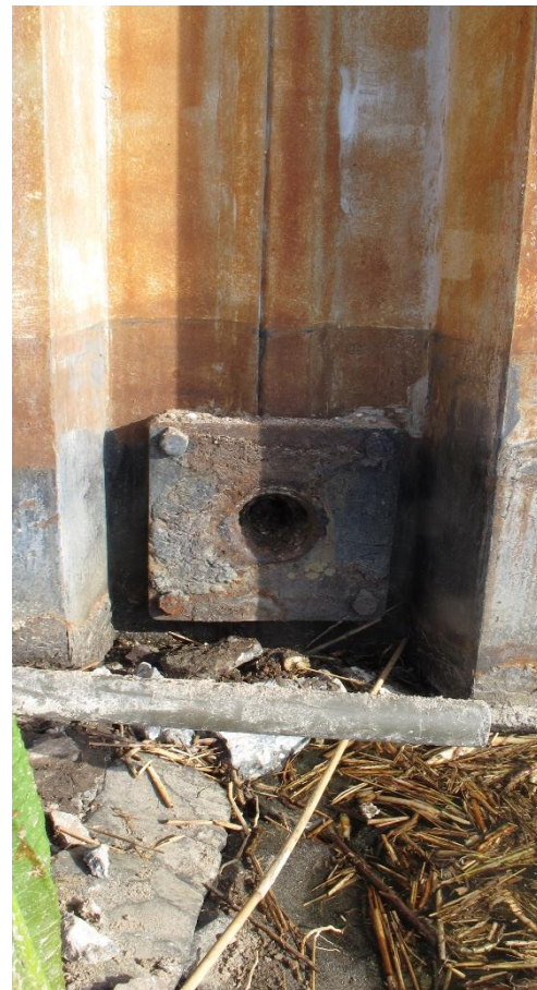
Figuur A.10 Montageplaat door damwand
