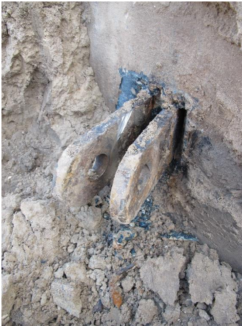
Figuur A.3 Muurbevestiging na verwijderen ankerroog.
