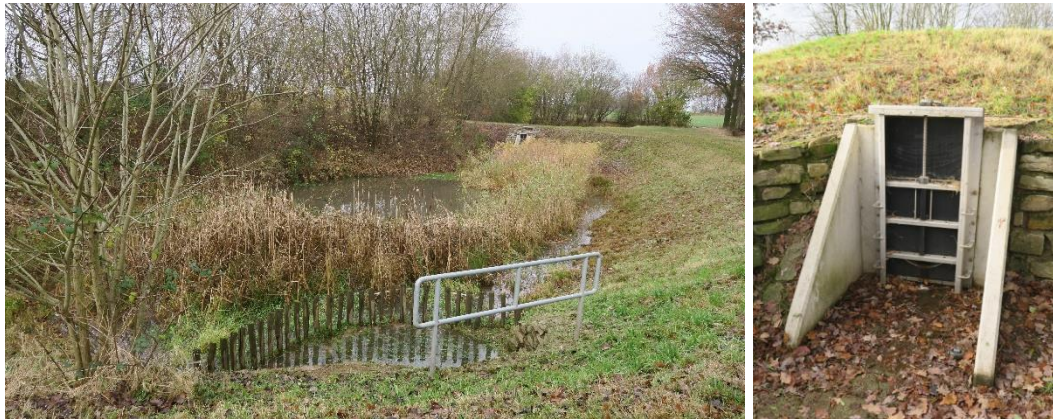
Figuur 5 Regenwaterbuffer Groenstergracht. Rechts de uitlaatconstructie (foto: N. Asselman)
