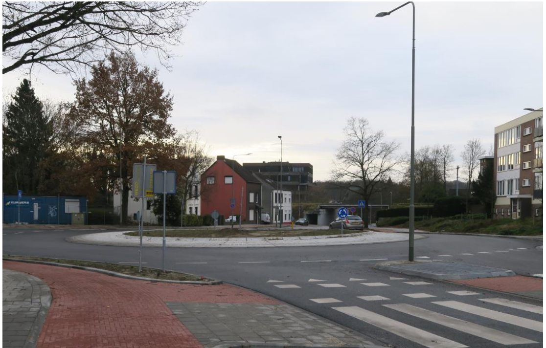
Figuur 6 Gekantelde rotonde op de kruising Waubacherweg – Rimburgerweg, gezien vanaf het noorden (Waubacherweg) (Foto: N. Asselman)
