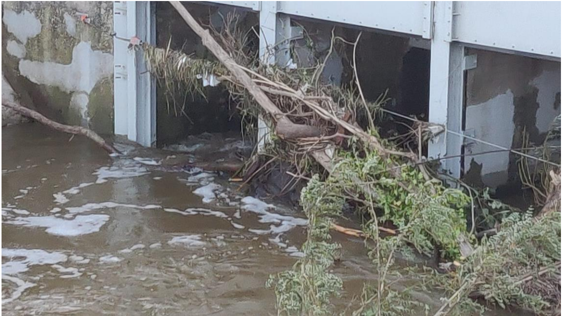
Figuur C.15 Drijfvuil bij de inlaat van de sifon na afloop van het hoogwater. Foto ontvangen van Waterschap Limburg
