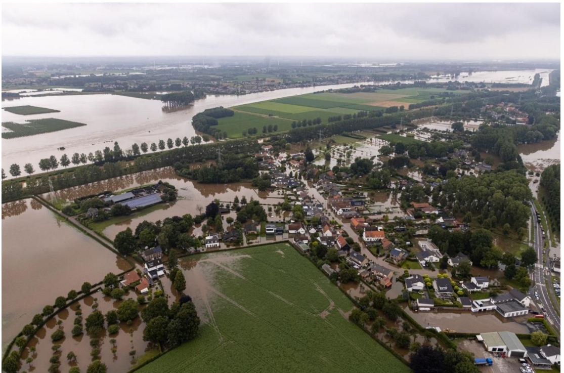
Figuur C.6 Overstroming Brommelen. Foto #54 van 16 juli 2021, vanuit het zuidoosten
