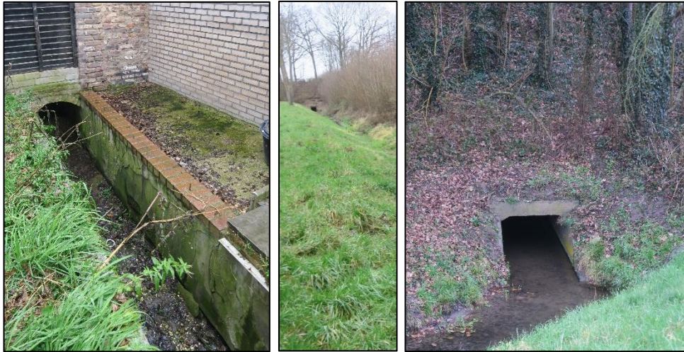
Figuur 3.11 Links: Verlegde broekgraaf door achtertuinen in Westbroek; Midden: in de verte de duiker onder de straat Westbroek (locatie 1 in Figuur 3.10); Rechts: duiker onder de brugweg/Essendijk (locatie 2 in Figuur 3.10). (foto's: N. Asselman)
