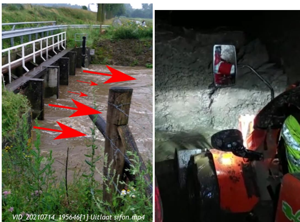
Figuur 4.8 Links: Beeld uit een video van de uitlaat van de sifon op 14 juli. Met pijlen is aangeven welke openingen duidelijk water afvoer (grote pijlen) en bij welke openingen dit niet zichtbaar is (kleine pijlen). Rechts: foto van onderhoudswerkzaamheden RWS-ZN, te zien is een shovel voor een grote laag slib
