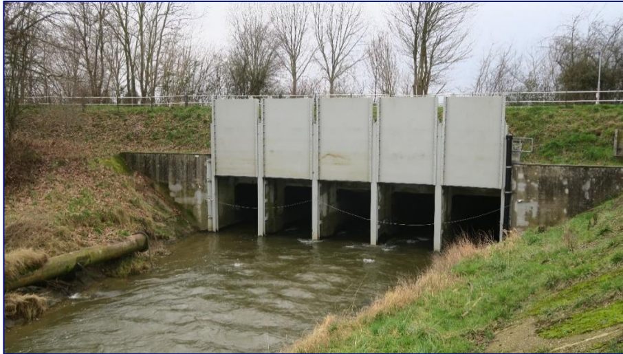
Figuur 4.2 Foto van de sifon onder het Julianakanaal, gezien vanaf de oostzijde tijdens lage afvoercondities (foto 4 februari 2022, N. Asselman)
