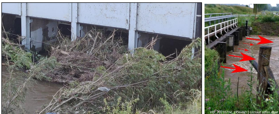
Figuur 4.5 Links: drijfvuil bij de inlaat van de sifon na afloop van het hoogwater van juli 2021 (Foto ontvangen van Waterschap Limburg). Rechts: beeld uit een video van de uitlaat van de sifon op 14 juli. Met pijlen is aangegeven welke openingen duidelijk water afvoer (grote pijlen) en bij welke openingen dit niet zichtbaar is (kleine pijlen)
