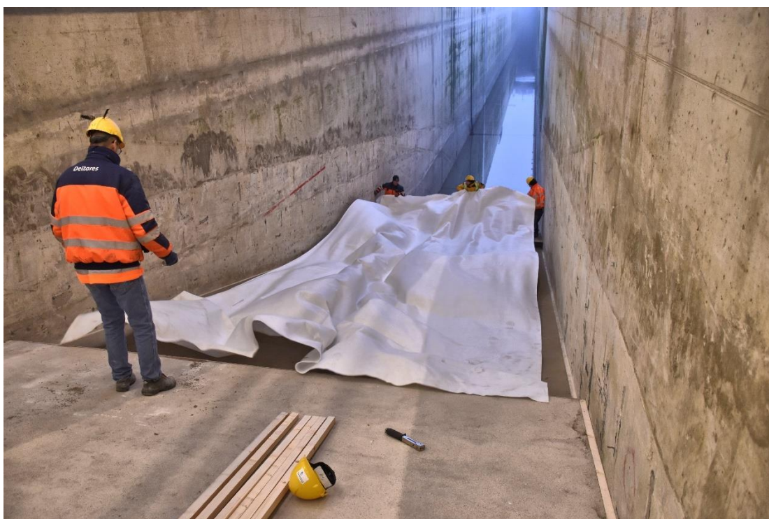
Fig. E-2 Aanbrengen geotextiel op het zandcement
