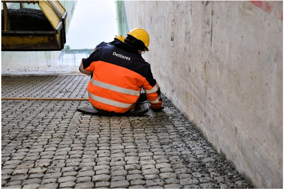
Fig. E-7 Aan de randen is de steenzetting met de hand ingewassen met steenslag
