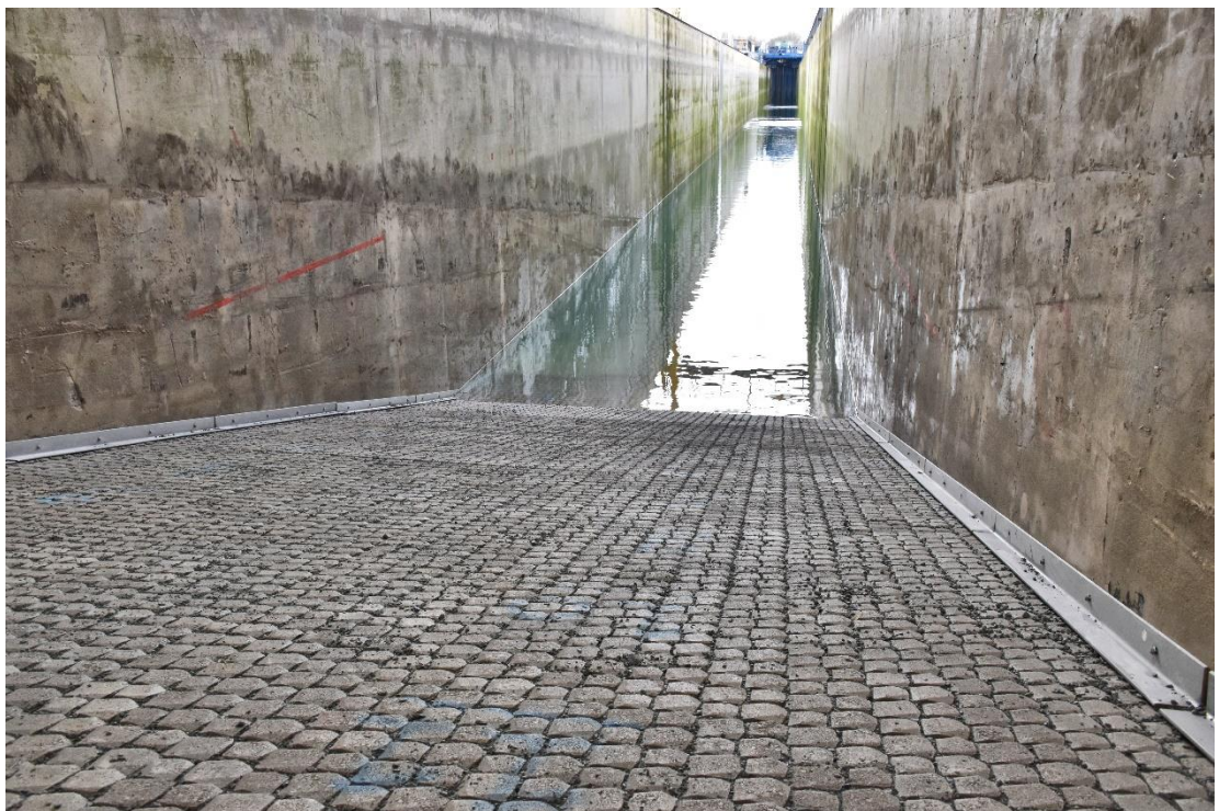
Fig. E-14 Overzicht van het talud na proef QB-01
