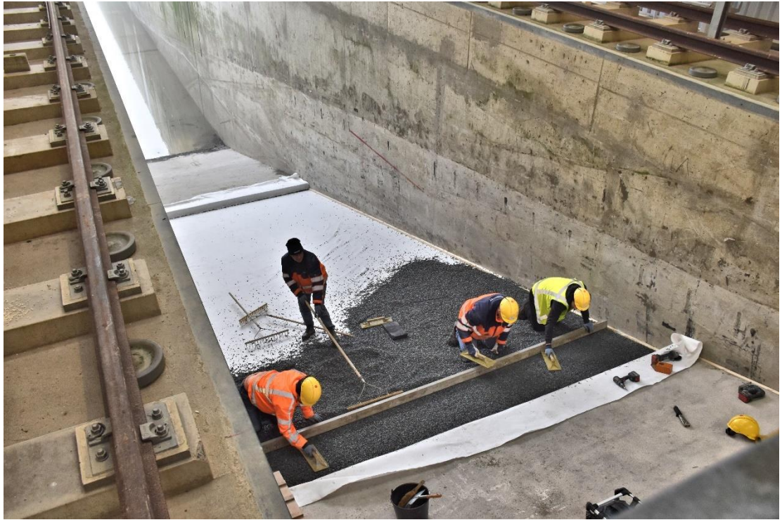
Fig. E-3 Aanbrengen van de filterlaag op het geotextiel
