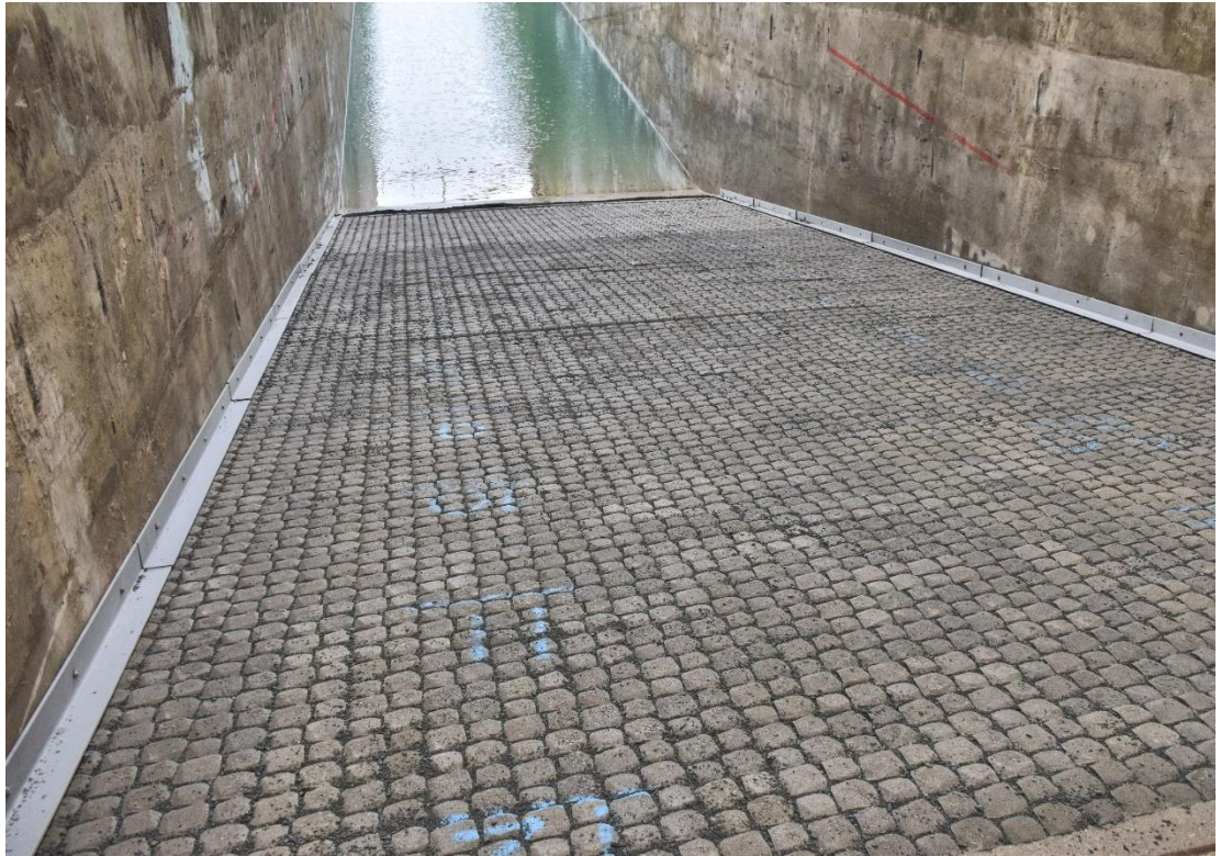
Fig. E-17 Taludoppervlak met minimale vervorming na proef QB-06
