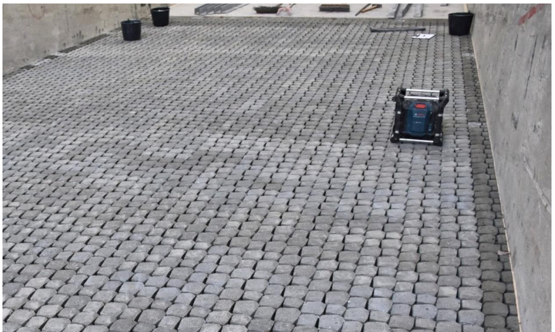
Fig. E-6 De ruimte tussen de zetstenen en de gootwand is opgevuld met rubber
