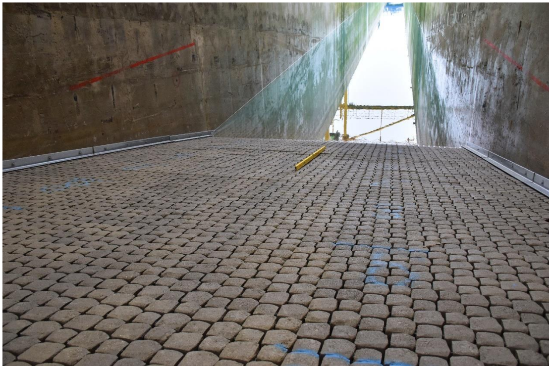
Fig. E-16 Taludoppervlak met minimale vervorming na proef QB-05
