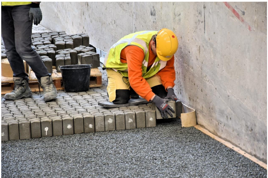
Fig. E-4 Plaatsing Quattroblocks op het filter
