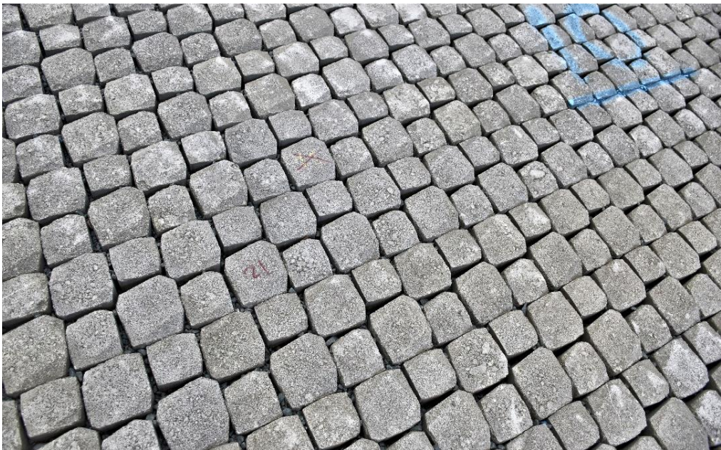
Figuur 4.6 Uitspoeling inwasmateriaal na QB-01 ter hoogte van meter 10 langs het talud
