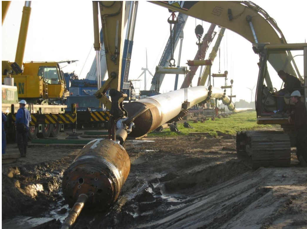
Figuur 2.1 Aanleg leiding middels HDD.
