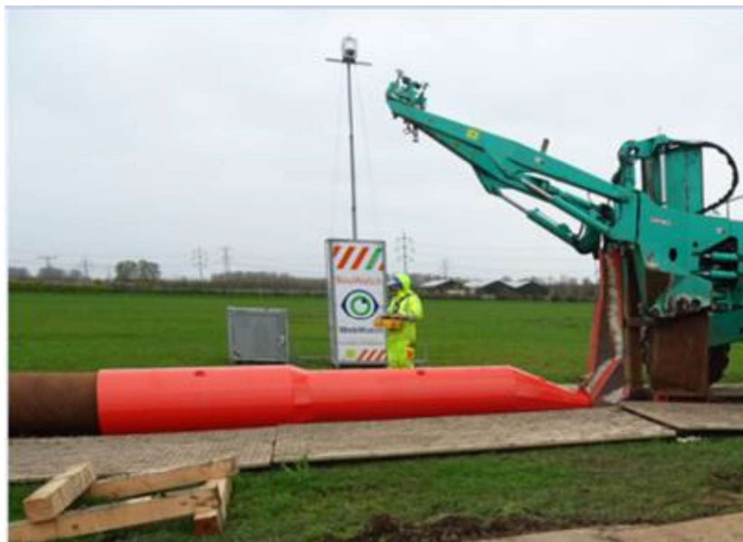
Figuur 2.4 Ploeg met aangekoppelde leiding, de oranje-rode buis is de zogenaamde torpedo (foto: Deltares).
