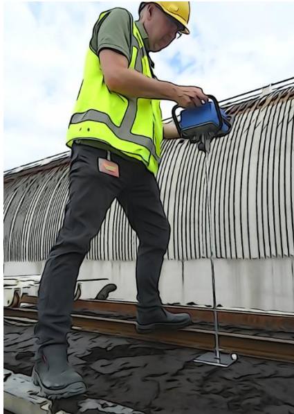
Figuur 2.15 Uitvoering penetrologger meting (foto: Deltares).
