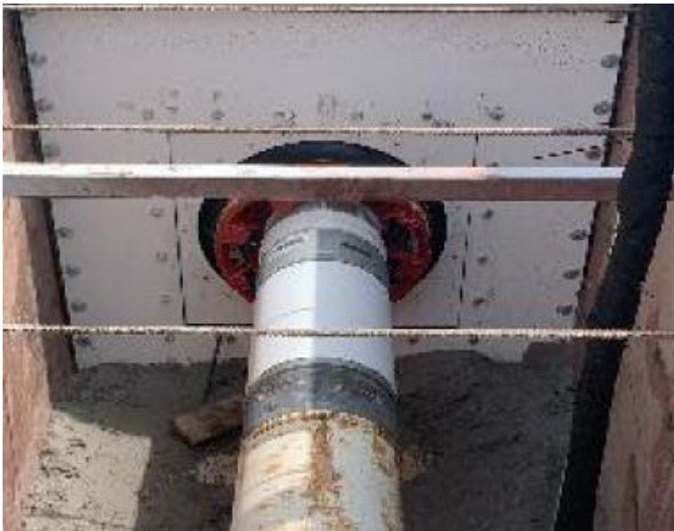
Figuur 2.8 EPP met ruimer op startpositie (foto: Herrenknecht).
