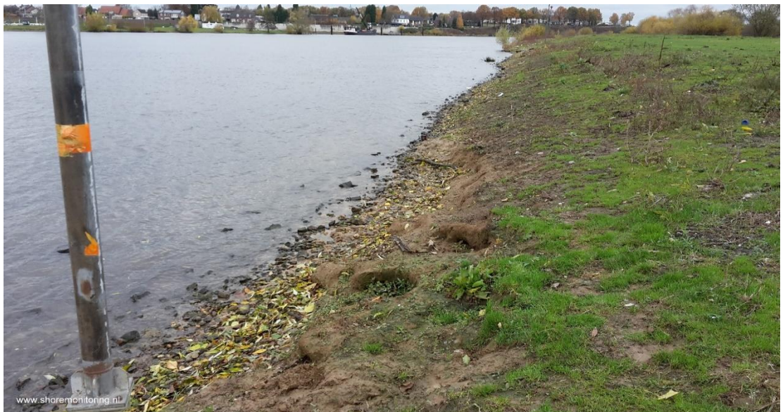
Figuur 3.5 Foto van de oever van Hansumerweerd ter hoogte van rkm. 88,9, genomen in benedenstroomse richting (Shore, 2016).
