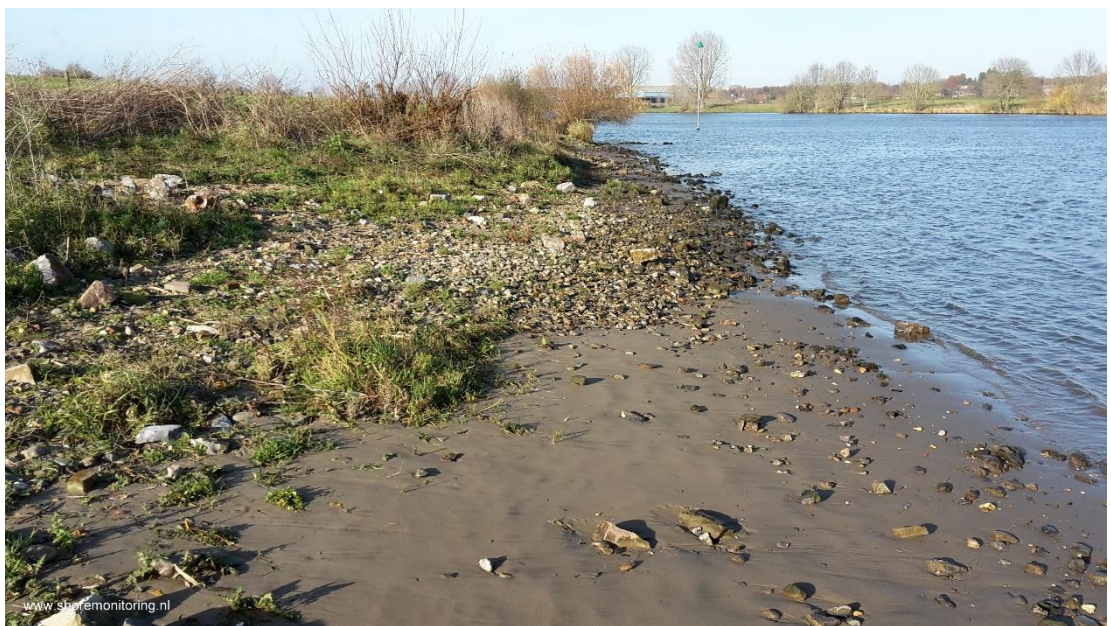
Figuur 3.27 Foto op de overgang naar het benedenstroomse einde van oever 8A. Zichtbaar zijn het steile talud en de overgang van het kale vlakke oeverstrand met enkele grote stenen naar een begroeid oeverstrand dat grotendeels bedekt is met grind (Shore, 2016).
