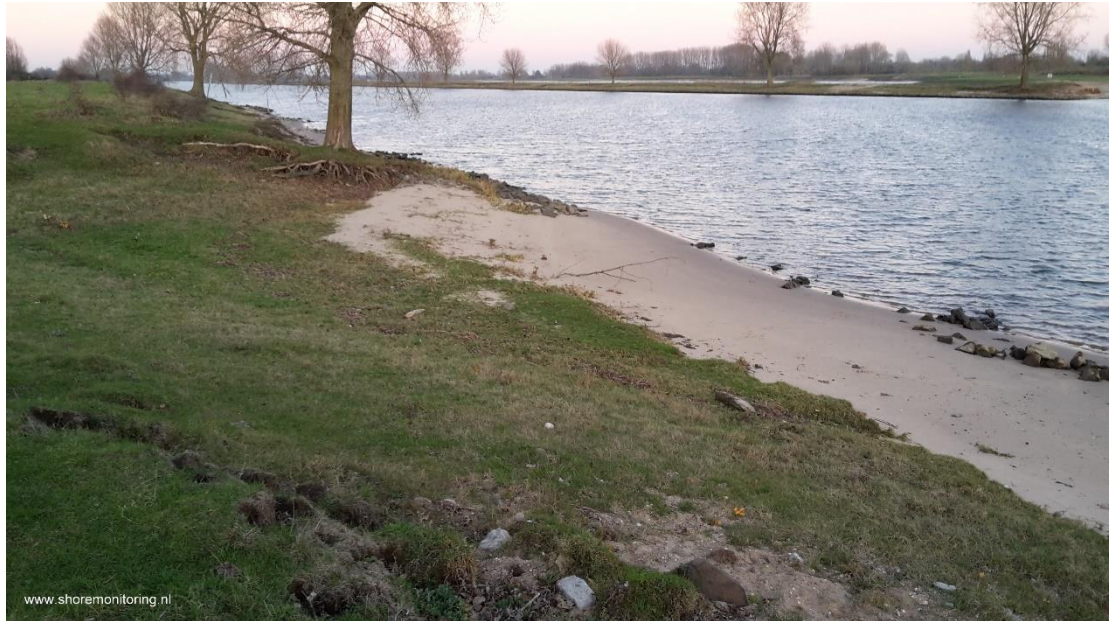
Figuur 3.24 Foto van de blootliggende wortels aan de zijkant van de bakenbomen en de nog aanwezige steenbestorting direct voor de bakenbomen (Shore, 2016).
