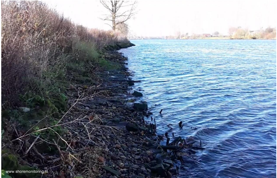
Figuur 3.32 Foto van de dichtbegroeide oever 8D met het steile oevertalud met brokken klei, hout, grind en stenen op een oeverstrand dat uit klei en zandlagen bestaat (Shore, 2016).
