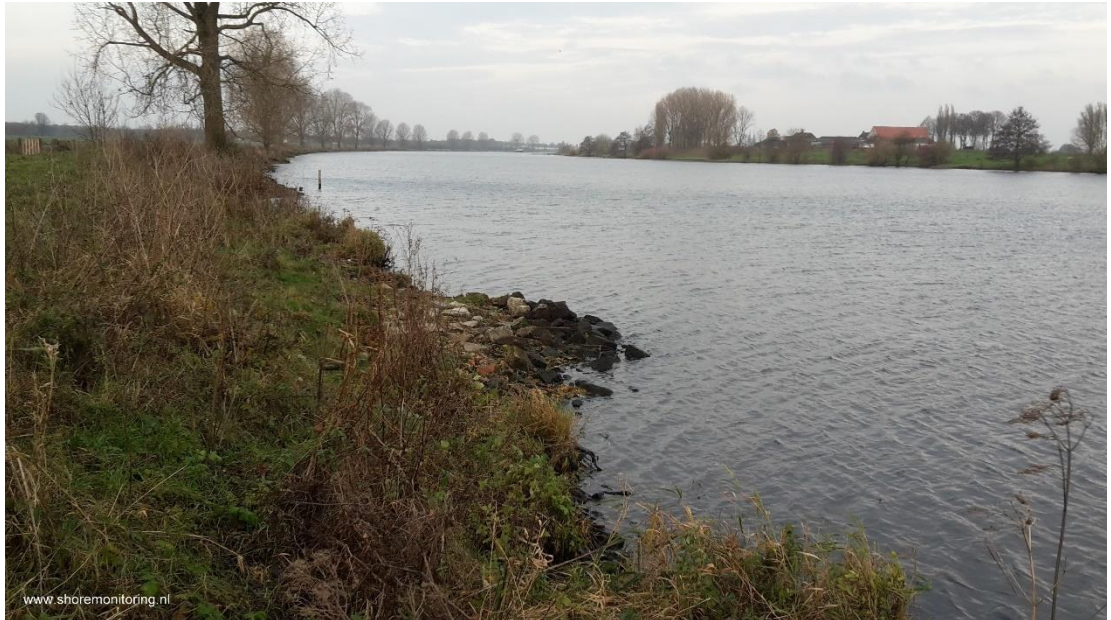
Figuur 3.33 Foto van een van de locaties langs oever 8E waar nog grote stenen aanwezig zijn, afkomstig van of de voormalige oeverbestorting, of van de kribben die hier in het verleden hebben gelegen (Shore,2016).
