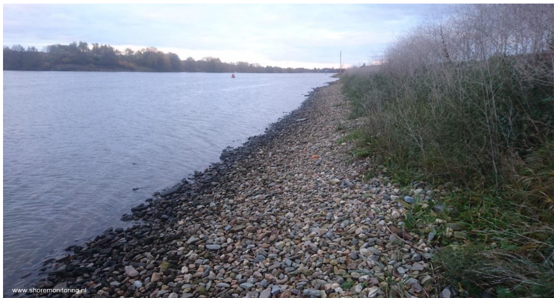
Figuur 3.11 Foto van oever 4A bij Beesel. Oeverbescherming is tot onder de waterlijn aanwezig. Er liggen stenen en grind op het oeverstrand en er is een begroeid steil talud tussen de top van het oeverstrand en de top van de oever (Shore, 2016).
