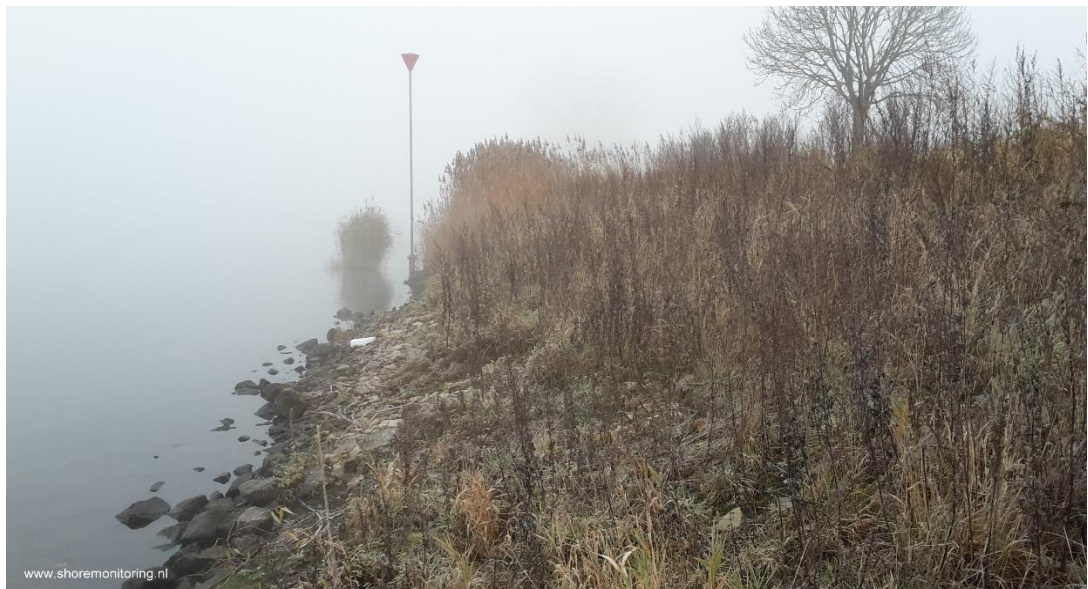
Figuur 3.15 Foto van de tot op de waterlijn aanwezige steenbestorting met grof grind en een steil begroeid talud bij oever 5A. De foto is genomen in benedenstroomse richting ter hoogte van rkm. 183,4 (Shore, 2016).
