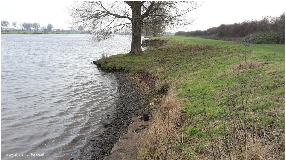
Figuur 3.36 Foto van de afwisseling langs oever 8F tussen de relatief hoge (achteraan) stukken kleioever met een hoge steilrand zonder oeverstrand, en de lagere (vooraan) stukken kleioever met een breder oeverstrand dat met grind is bedekt (Shore, 2016).
