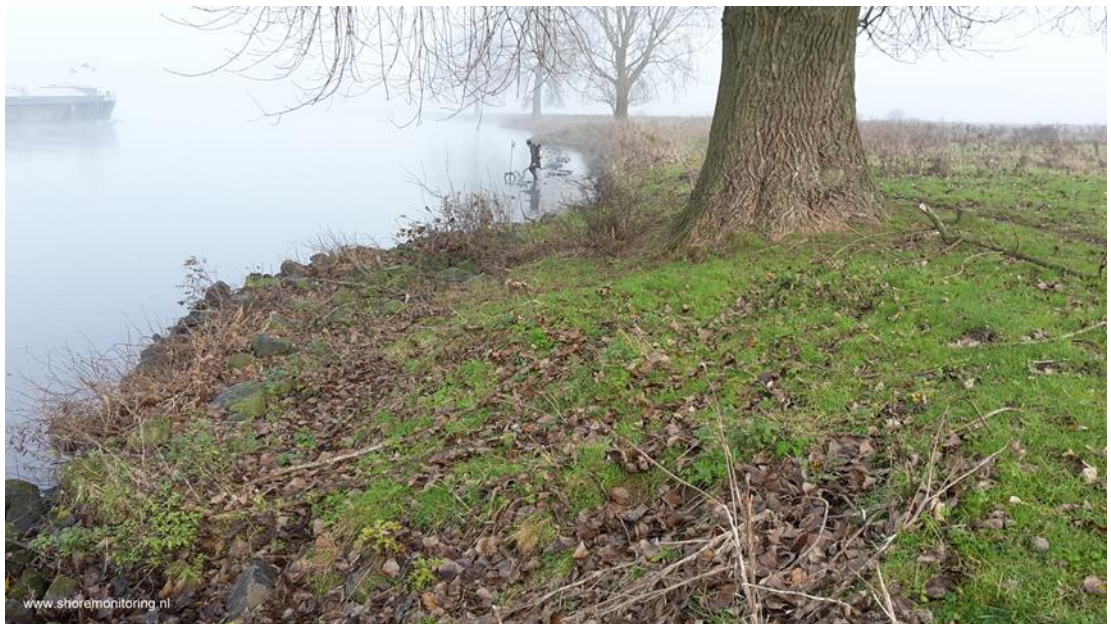
Figuur 3.21 Foto van de komvormige oever tussen twee bakenbomen waarbij de steenbestorting voor de bomen is gehandhaafd tot op de oever (Shore, 2016).
