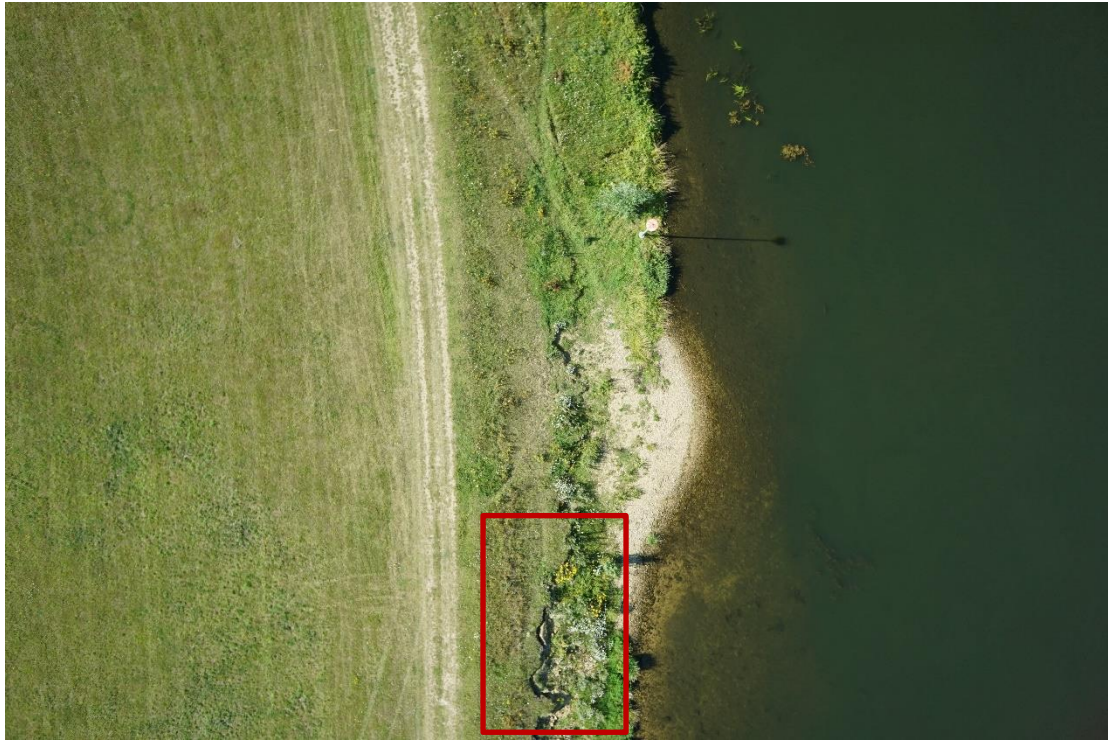
Figuur 4.23 luchtfoto van de steilrand met in het rode kader de (afgeschoven) brokken erosieproduct bij oever 4B (Shore, 2020).
