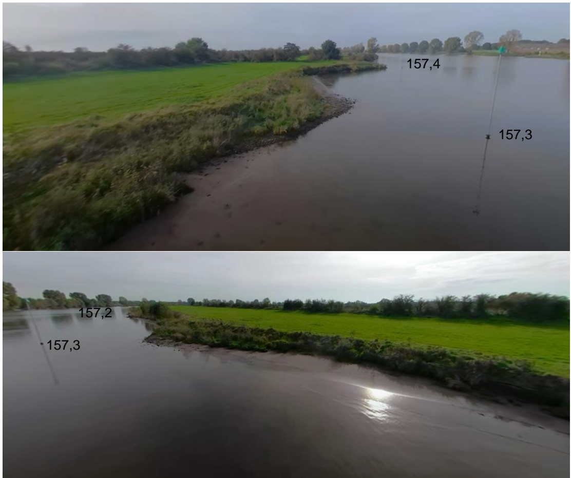
Figuur 4.9 Screenshots, zowel in benedenstroomse (boven) als bovenstroomse richting (beneden) van de erosiekommen in secties 4 en 5 van oever 8B. Zichtbaar zijn het brede geleidelijke zandige oeverstrand in de erosiekommen, de begroeide, afgegleden erosieproducten en de lokaal aanwezige steenbestorting ter hoogte van het baken bij rkm. 157,2 ; 157,3 en 157,4 (Shore, 2021).
