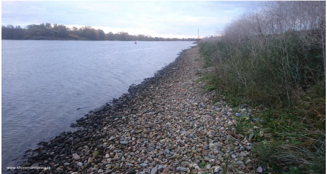
Figuur 4.18 Foto van oever 4A bij Beesel. Oeverbescherming is tot onder de waterlijn aanwezig. Er liggen stenen en grind op het oeverstrand en er is een begroeid steil talud tussen de top van het oeverstrand en de top van de oever (Shore, 2016).
